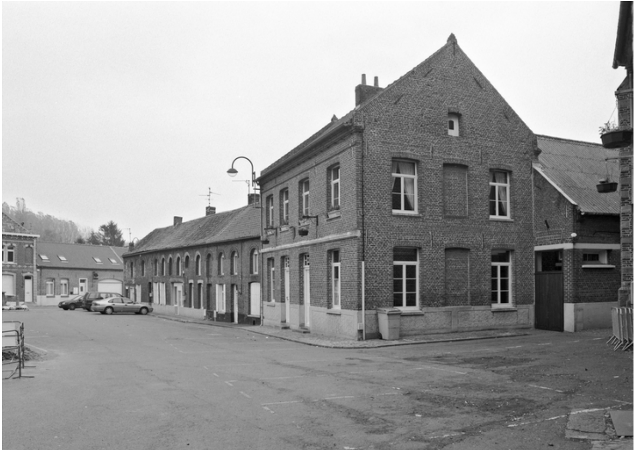
Vue de la mairie et du rang de maisons depuis l'église.
