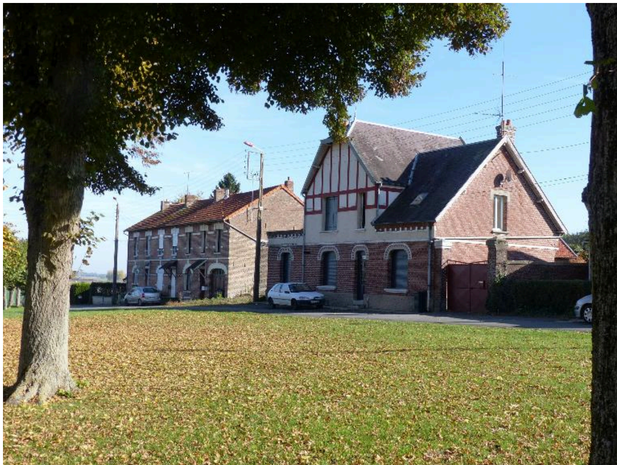
Maisons, à l'extrémité de l'avenue. Au premier plan, logis de ferme reconstruit sur les plans de l'architecte Hamiant, 1927.
