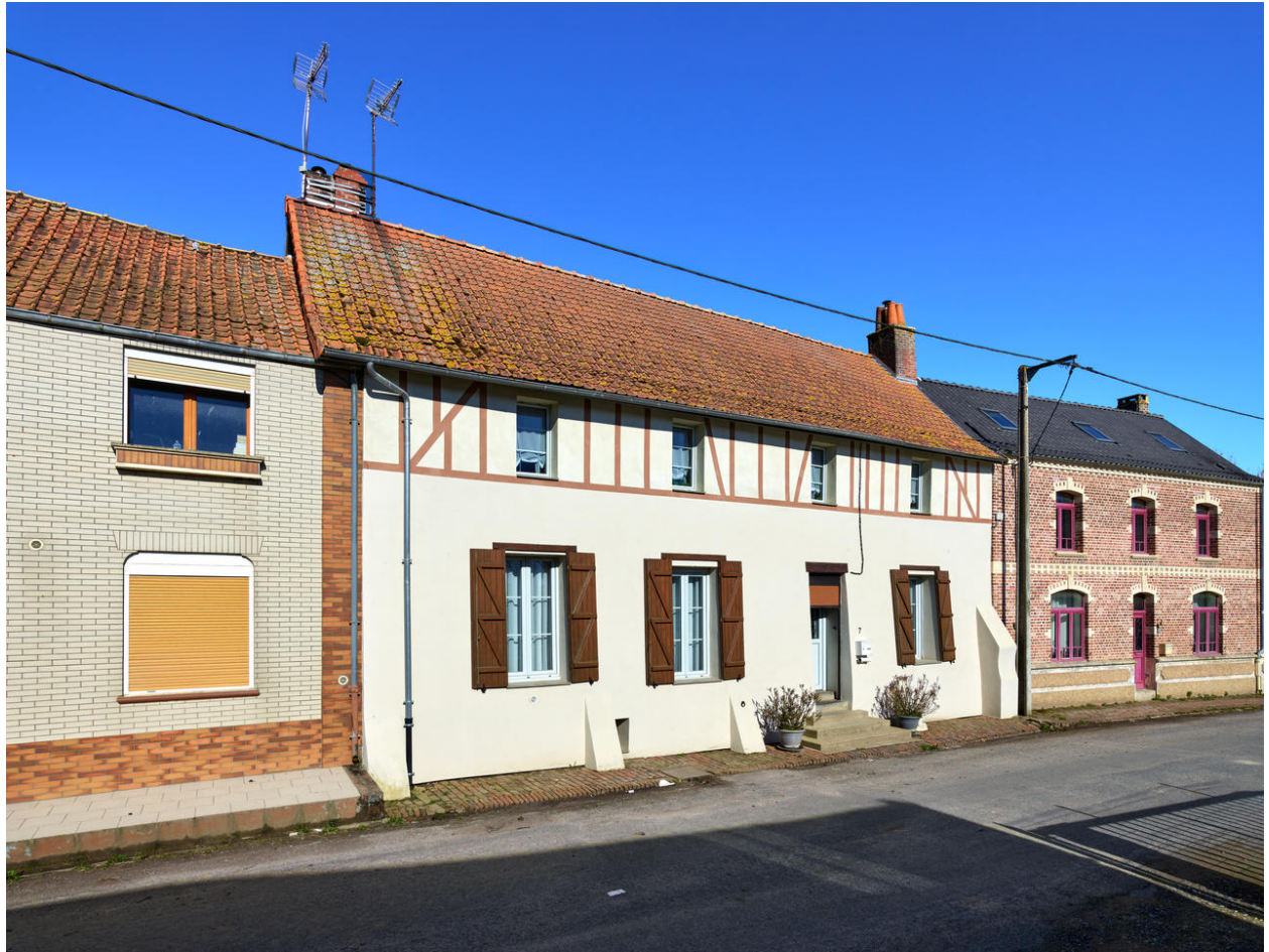
Vue générale de la façade.
