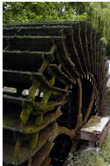
La roue hydraulique verticale remontée sur le site, vue de trois-quarts.
