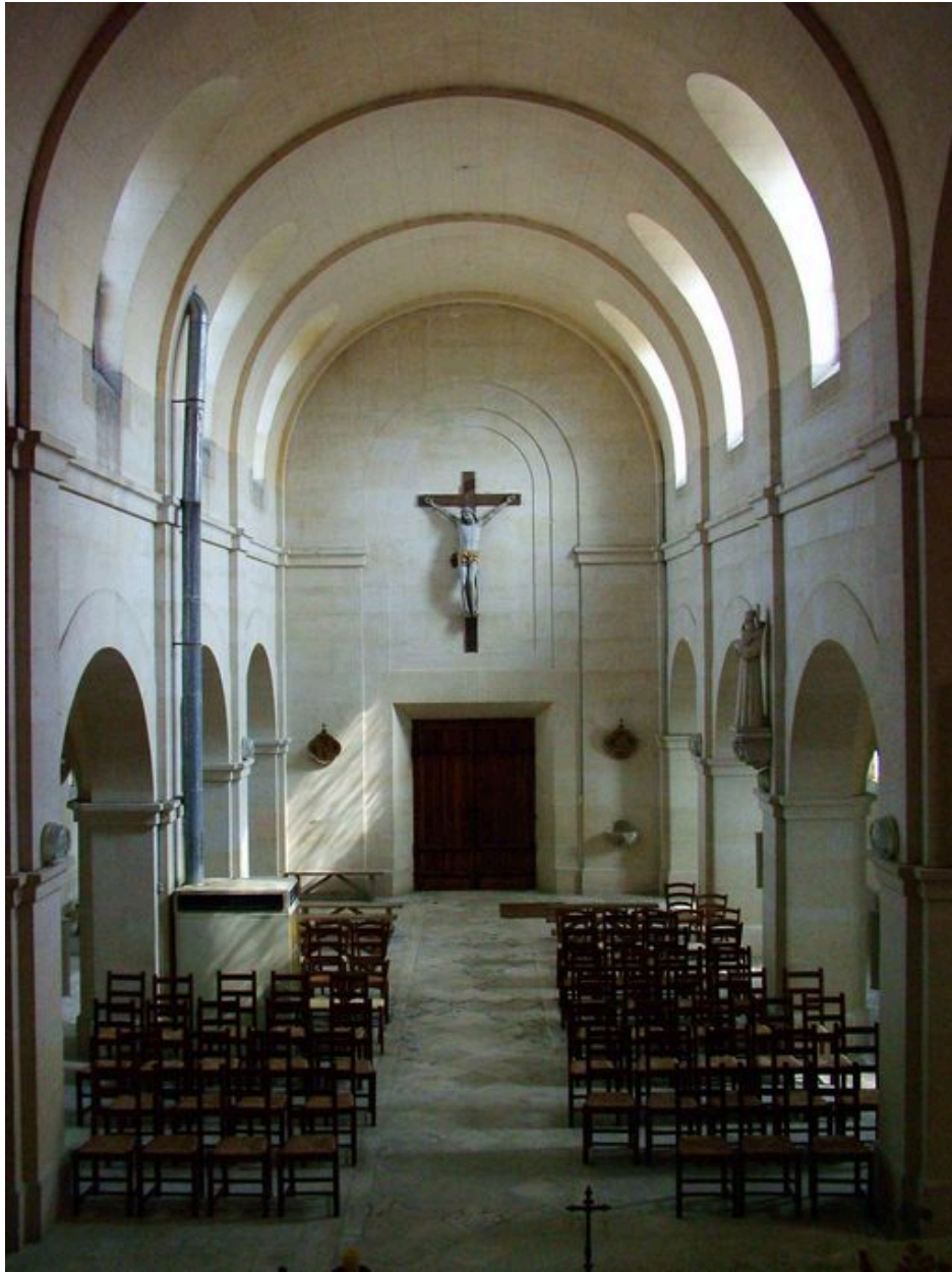
Vue intérieure de l'édifice.
