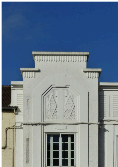
Vue de détail sur le fronton de l'ancien garage Gueudet.
