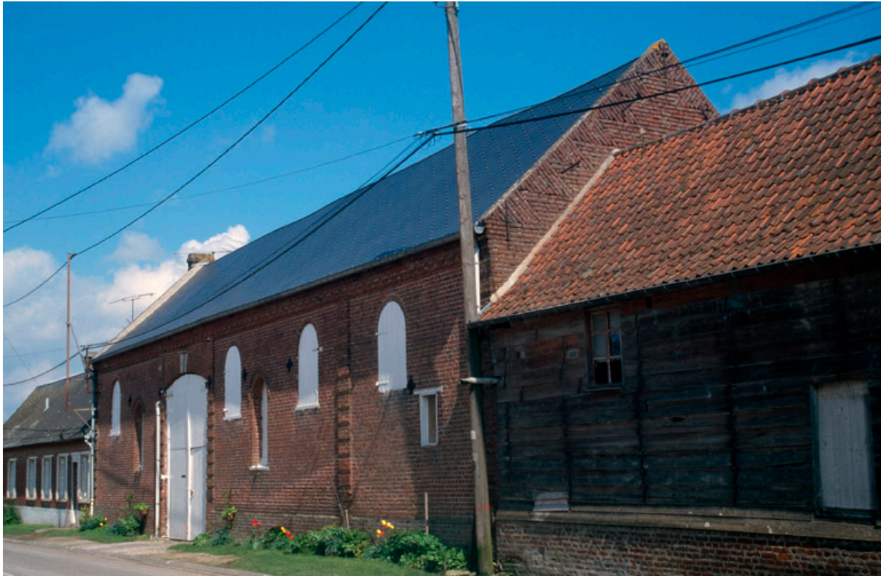
L'alignement sur rue, vu du sud-est.
