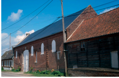
L'alignement sur rue, vu du sud-est. Phot. Judith Förstel IVR22_19998000794ZA
