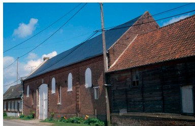
L'alignement sur rue, vu du sud-est.
