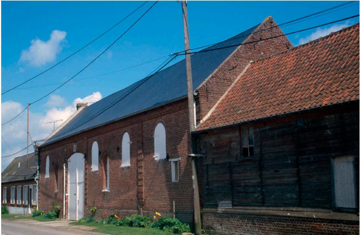
L'alignement sur rue, vu du sud-est.
