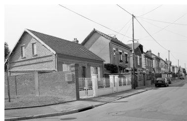
La cité ouvrière Dupont dans le quartier Saint-Jean. Phot. Laurent Jumel IVR22_19966002877X
