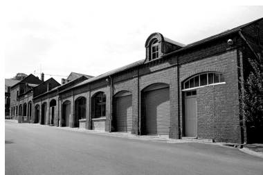
Remise à automobiles et écurie. Phot. Laurent Jumel IVR22_19966002838X
