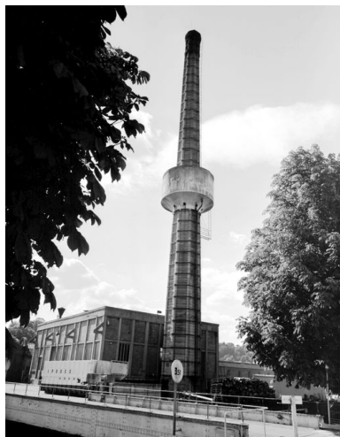
La cheminée d'usine et la salle des machines. Phot. Laurent Jumel IVR22_19966002835X
