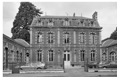
le logement patronal, façade sur rue. Phot. Laurent Jumel IVR22_19966002847X
