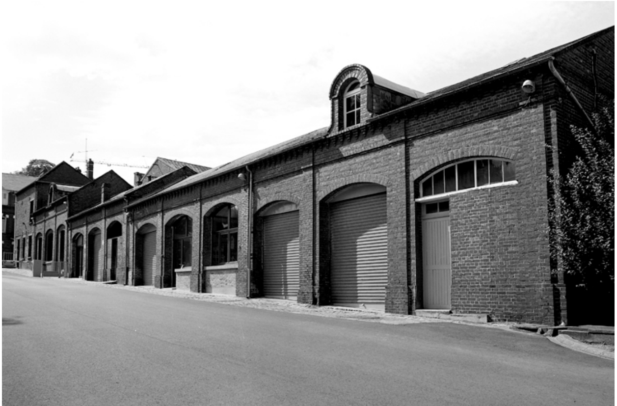
Remise à automobiles et écurie.
