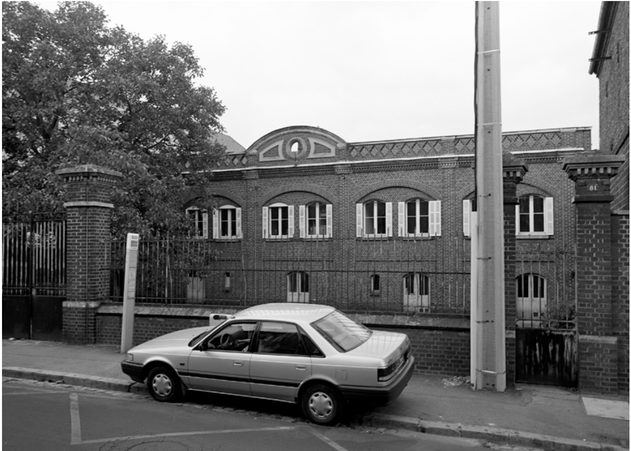
Les logements de contremaîtres, façade sur rue.
