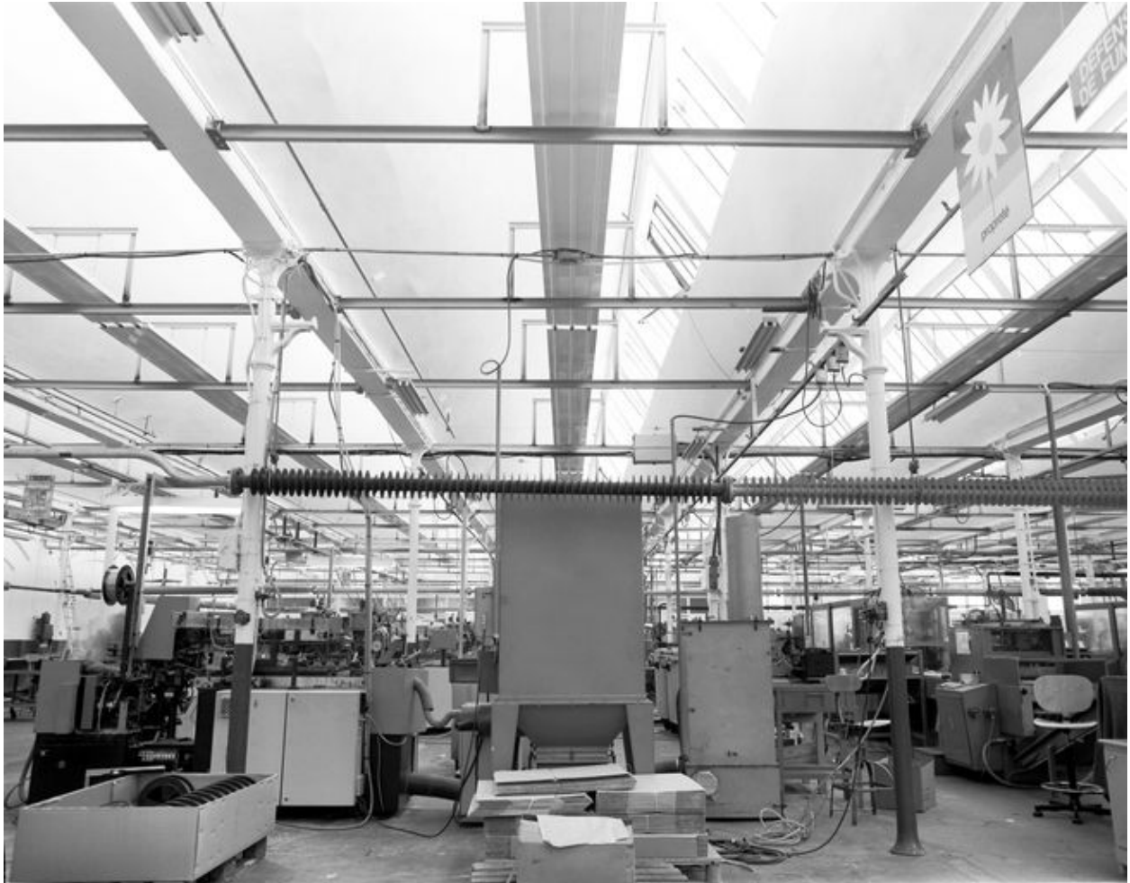
Intérieur de l'atelier de fabrication avec détail des piliers en fonte.
