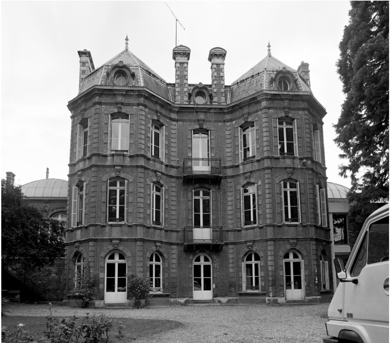
Le logement patronal, façade postérieure.
