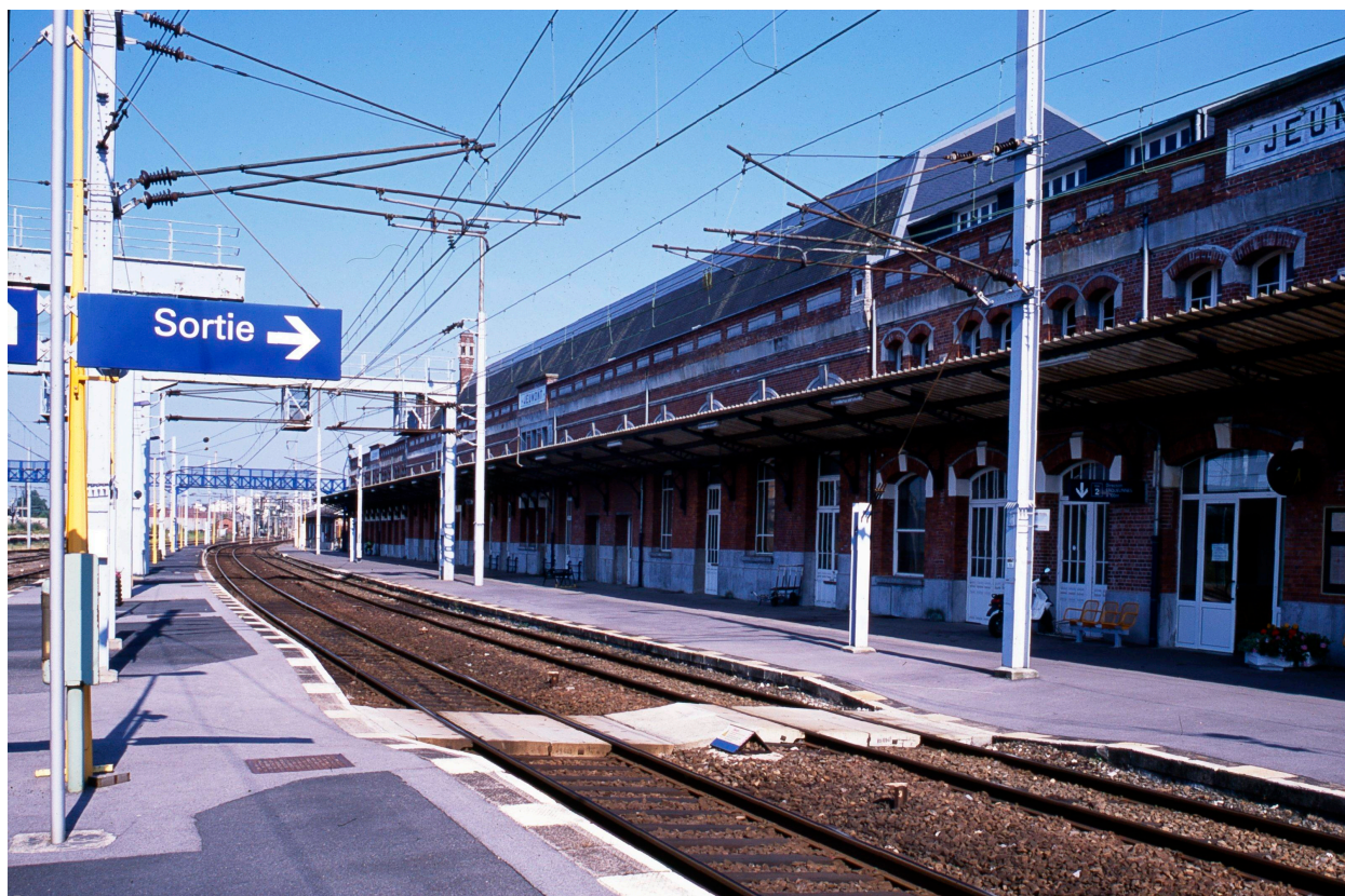
Vue générale de l'élévation postérieure (nord).
