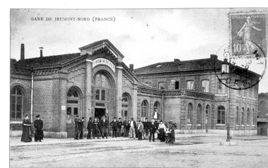
Vue partielle de l'élévation antérieure de l'ancienne gare, carte postale ancienne, sans date. In ROUSSELLE, Christian et DESSAGER, André. Mémoire en images : Jeumont et Marpent. Joué-lès-Tours : Alan Sutton, 1997, p. 40. Repro. Pierre Thibaut IVR31_20015902111ZB
