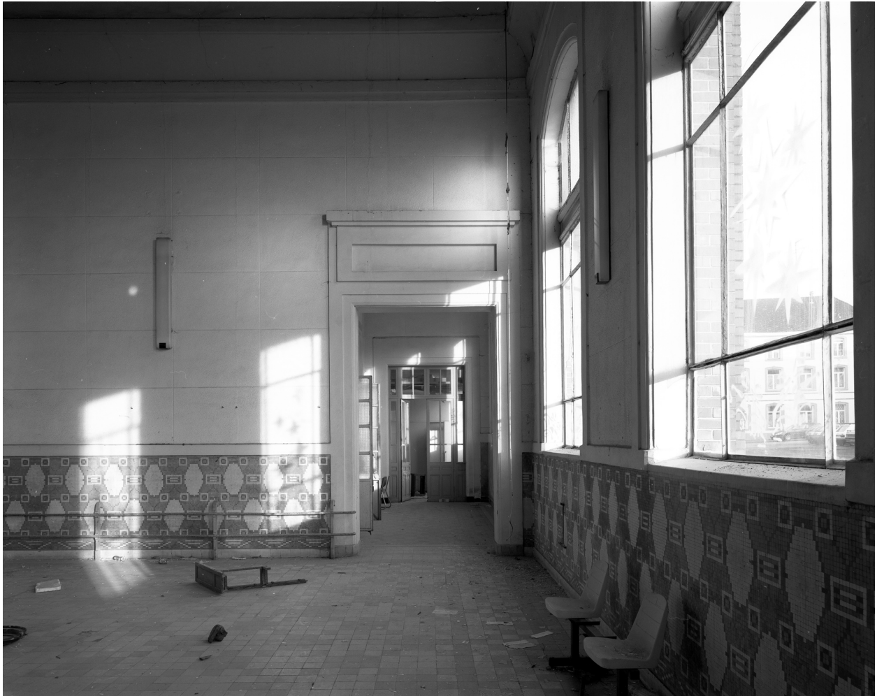
Décor de mosaïque de la salle des pas perdus et enfilade des bureaux de la douane.
