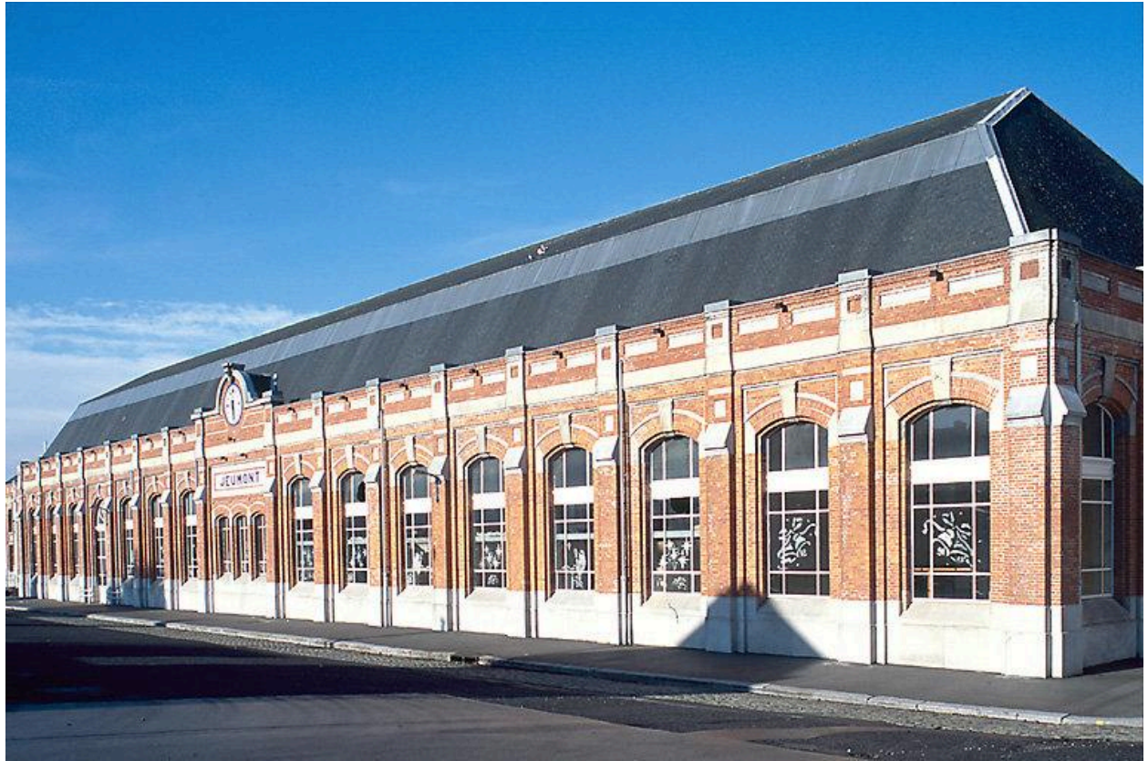
Vue de trois quarts de l'élévation antérieure (sud).
