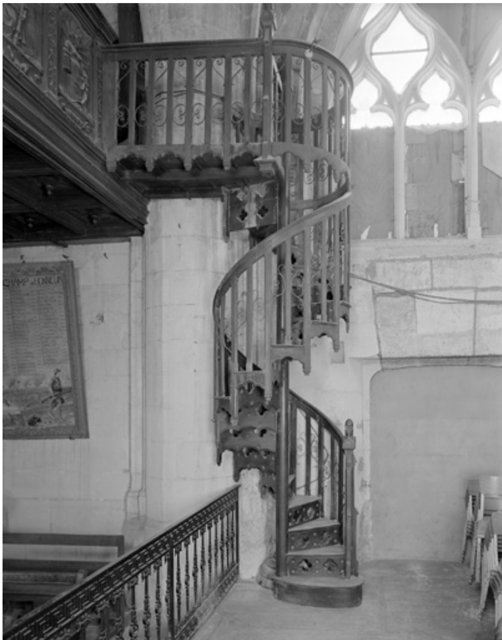
Escalier livré par la maison Haussaire, métal et bois, 19e siècle, vue d'ensemble.
