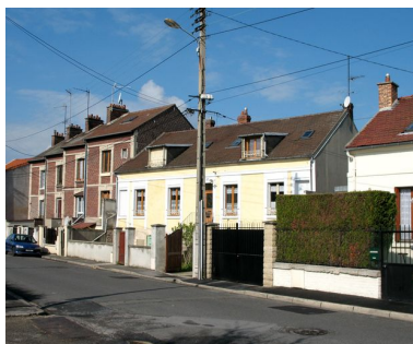
Maison d'habitation construite vers 1906. Phot. Clarisse Lorieux IVR22_20086005172NUCA
