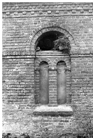
Elévation nord de la grange : détail d'un motif architectural antiquisant. Phot. Pierre-Yves Brest IVR22_19980202465Z
