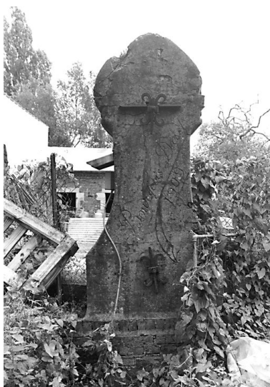
Puits de style Art Nouveau : élévation postérieure avec la signature 'Daret-Bourgeois 1909'. Phot. Pierre-Yves Brest IVR22_19980202527Z
