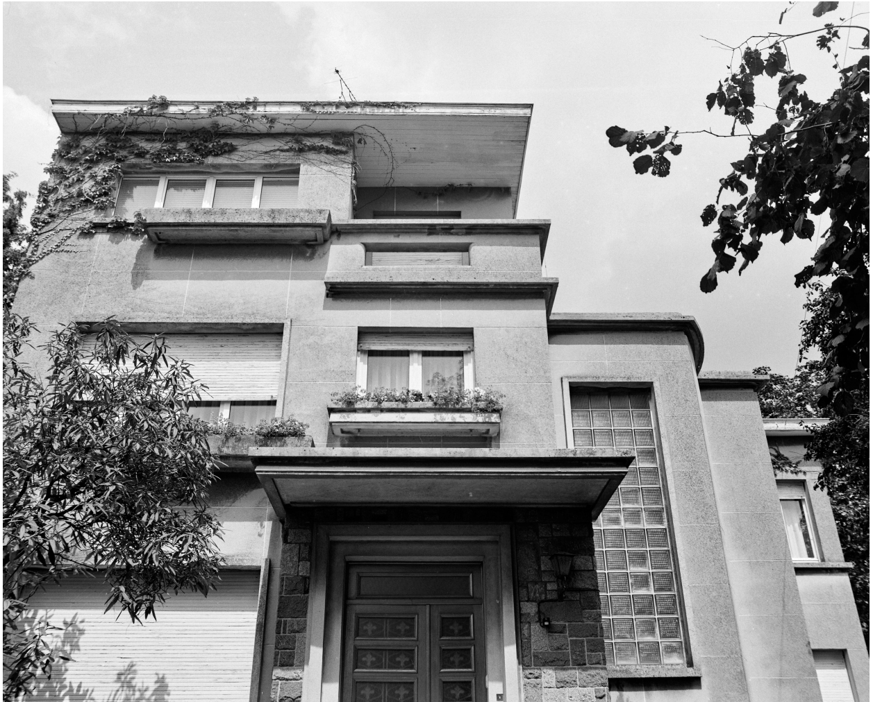
Vue en contre-plongée accentuant les décrochements.
