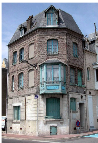
Vue d'ensemble depuis l'avenue du Maréchal-Foch. Phot. Elisabeth Justome IVR22_20038005335NUCA
