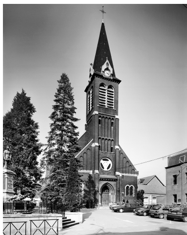
Élévation antérieure. Phot. Thierry Petitberghien IVR31_20025901009V
