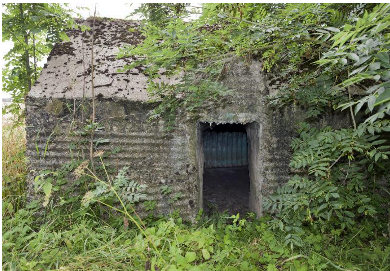
Entrée sur l'élévation nord-est, rue des Sûres
