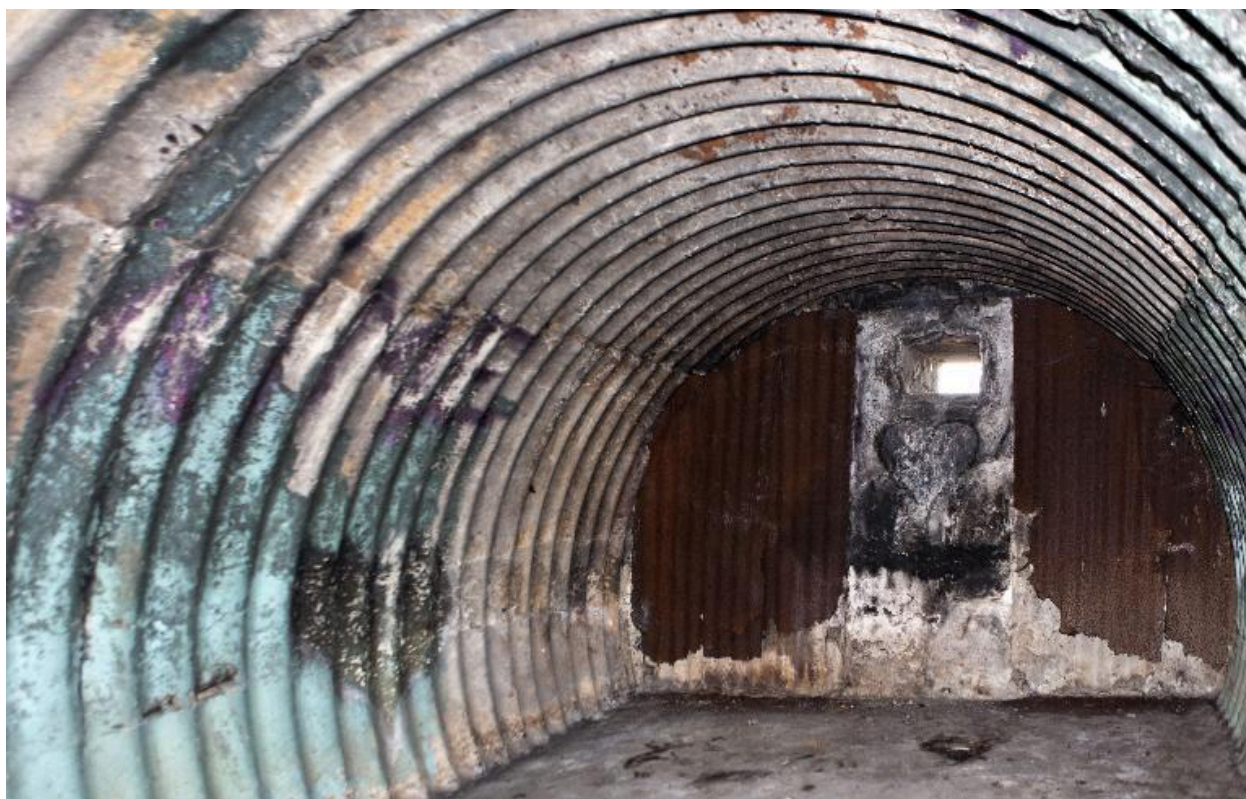
Vue intérieure de l'abri, vers le nord-ouest
