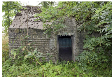
Entrée sur l'élévation nord-est, rue des Sûres Phot. Jean-Marc Ramette IVR31_20145905280NUCA
