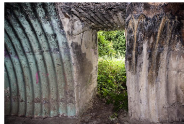
Entrée depuis l'intérieur Phot. Jean-Marc Ramette IVR31_20145905283NUCA
