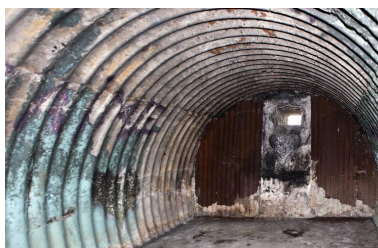
Vue intérieure de l'abri, vers le nord-ouest Phot. Jean-Marc Ramette IVR31_20145905282NUCA
