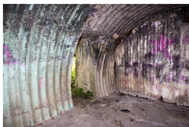
Entrée depuis l'intérieur Phot. Jean-Marc Ramette IVR31_20145905284NUCA
