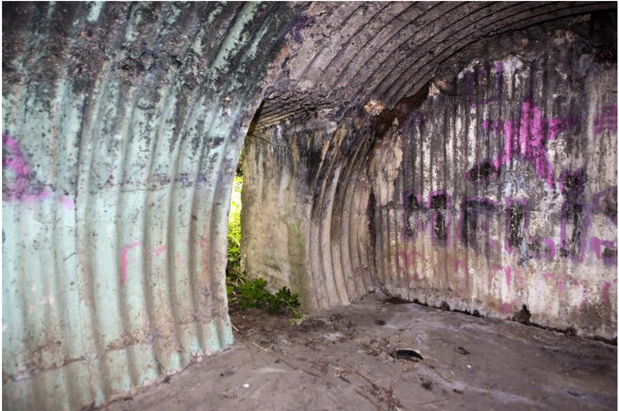
Entrée depuis l'intérieur
