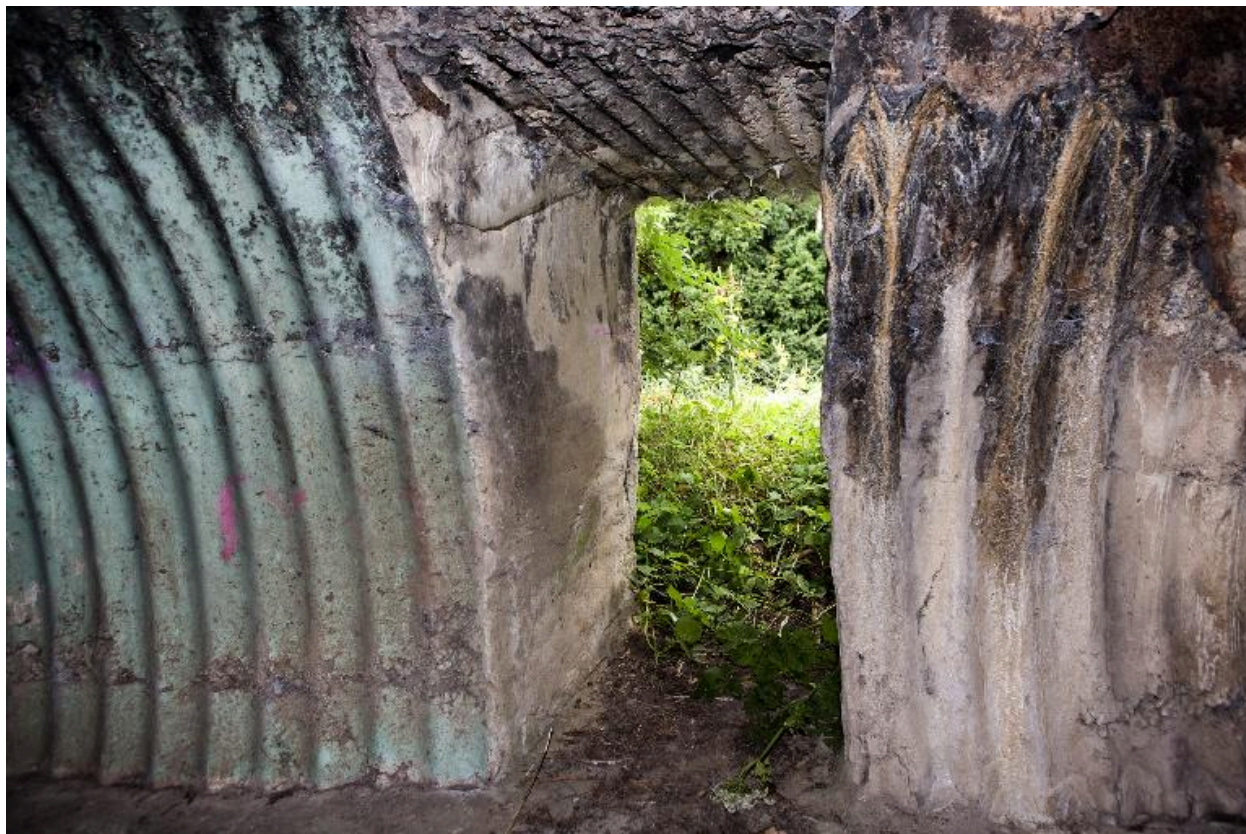
Entrée depuis l'intérieur
