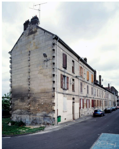
Vue générale de la cité ouvrière Lucile. Phot. Thierry Lefébure IVR22_20076000020VA
