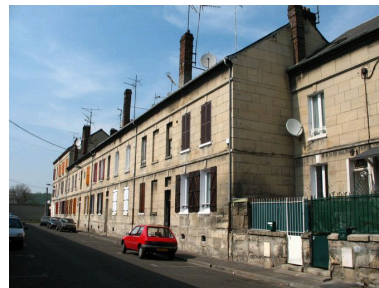
La cité ouvrière Lucile. Phot. Clarisse Lorieux IVR22_20076005241NUCA
