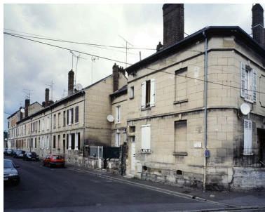
Les logements de la cité ouvrière Lucile depuis la rue des Usines. Phot. Thierry Lefébure IVR22_20076000019VA
