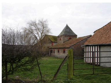
Vue postérieure du bâtiment comportant un pigeonnier (face est des bâtiments bordant le côté oriental de la cour). Phot. Catherine Fourmond IVR22_20058001369NUCA
