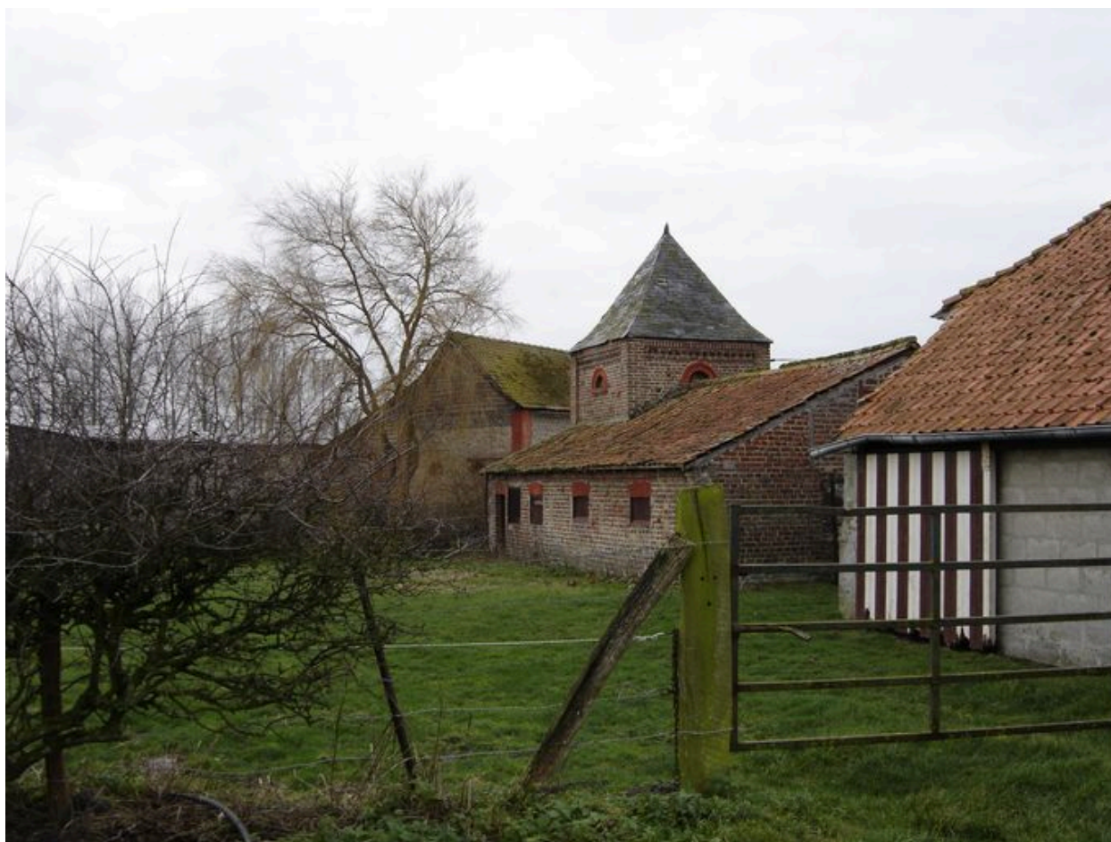
Vue postérieure du bâtiment comportant un pigeonnier (face est des bâtiments bordant le côté oriental de la cour).
