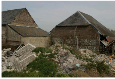
Vue postérieure de la charretterie. Phot. Inès Guérin IVR22_20078006231NUCA
