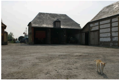
Vue de la charretterie située dans l'angle sud-ouest de la cour, aujourd'hui disparue. Phot. Inès Guérin IVR22_20078006230NUCA
