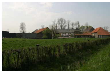
Vue d'ensemble depuis l'est. Phot. Irwin Leullier IVR22_20078000194NUC2A
