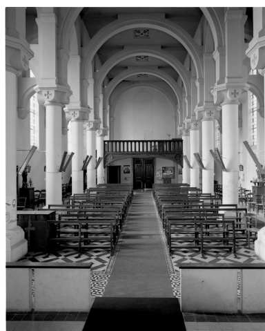
Vue intérieure depuis le chœur vers l'entrée.
