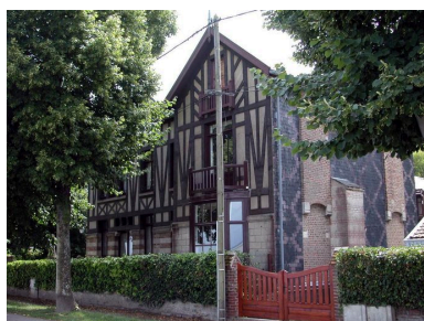
Vue d'ensemble sur la façade antérieure. Phot. Elisabeth Justome IVR22_20038005408NUCA
