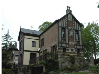
Vue de trois-quarts sur façades postérieure et latérale de la maison La Tour. Phot. Elisabeth Justome IVR22_20048001424NUCA
