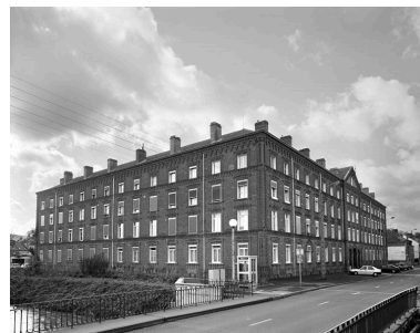
Vue des façades sur rue.
