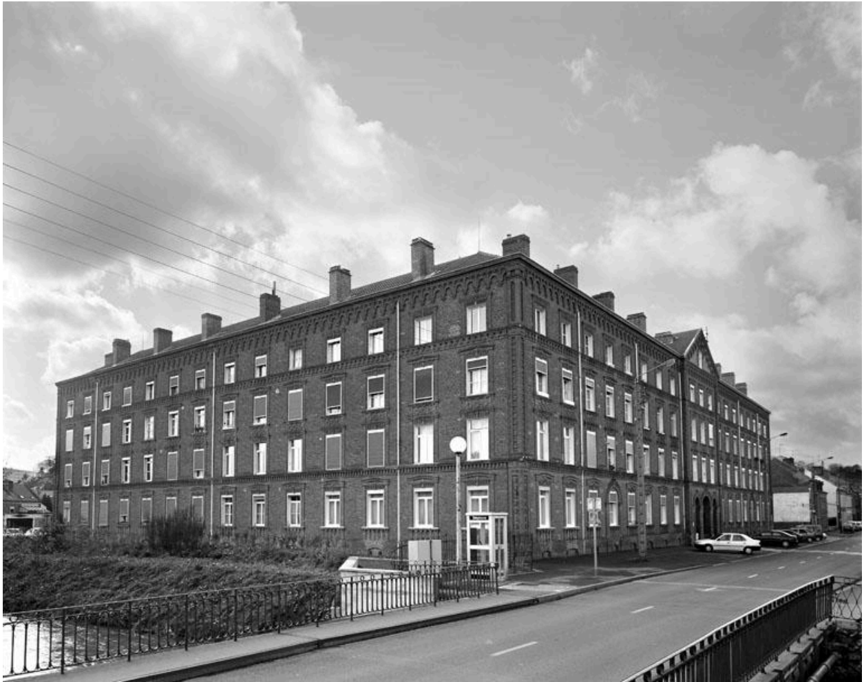
Vue des façades sur rue.
