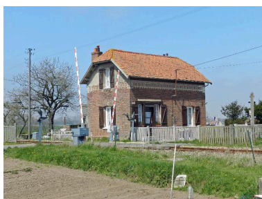
Maison de garde-barrière, rue Camille-Pelletan. Phot. Romain Grimaud IVR22_20138015593NUCA
