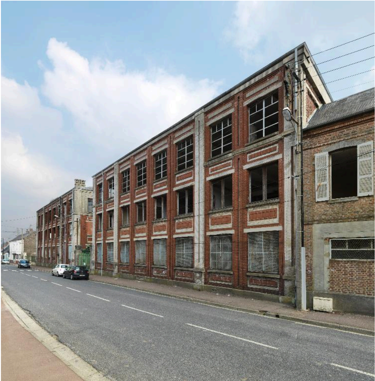
L'ancienne usine Guerville-Riquier, puis Bricard.
