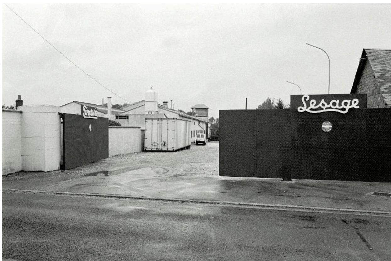
Fonderie Lesage, entrée du site, 75 rue Jean-Baptiste-Clément.
