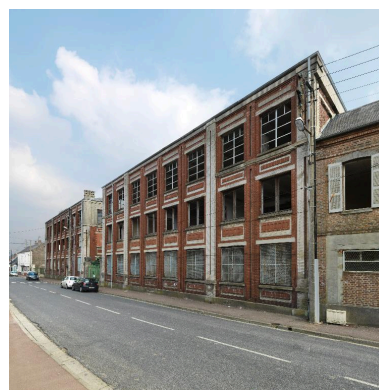
L'ancienne usine Guerville- Riquier, puis Bricard. Phot. Thierry Lefébure IVR22_20138000001NUC2AQ
