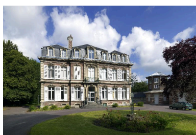
L'ancienne demeure d'Ernest Riquier. Phot. Thierry Lefébure IVR22_20158000556NUC2A
