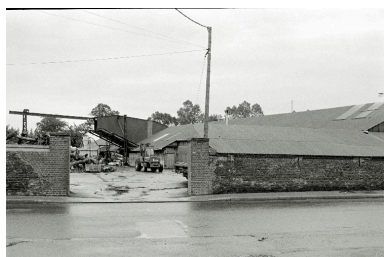
La scierie Pruvost, rue du Chevalier-de-la-Barre. Phot. Francis Dubuc IVR22_19908000055Z
