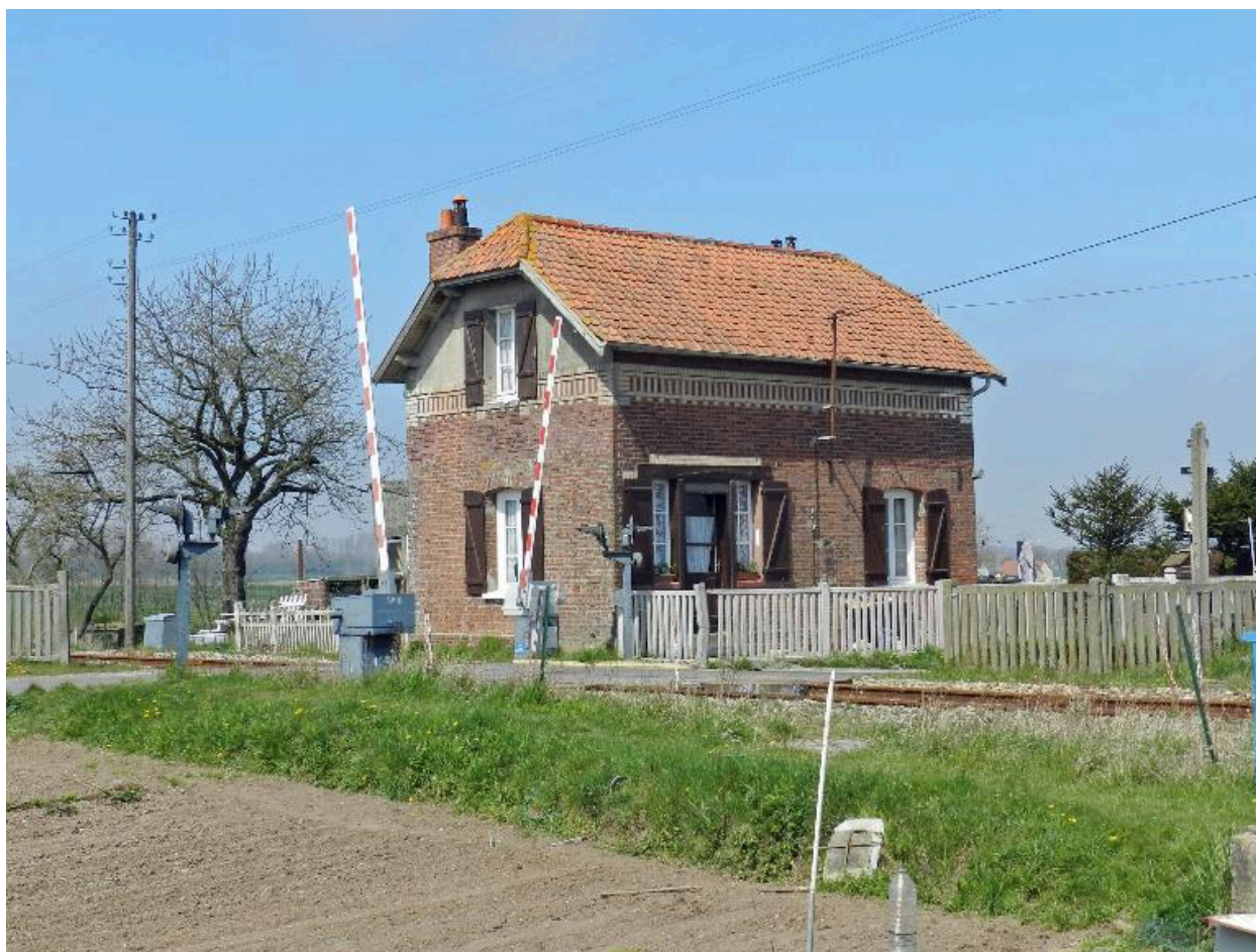
Maison de garde-barrière, rue Camille-Pelletan.
