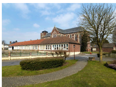
L'école mixte depuis le square du Château-brûlé. Phot. Thierry Lefébure IVR22_20138000049NUC2A
