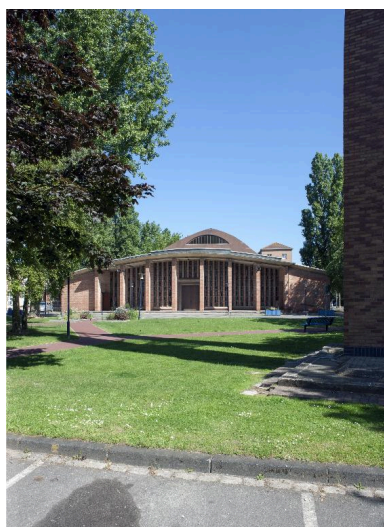
Élévation antérieure de l'église, depuis le clocher. Phot. Pierre Thibaut IVR31_20155900277NUCA
