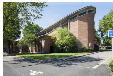
Élévation postérieure de l'église et flanc droit. Phot. Pierre Thibaut IVR31_20155900275NUCA
