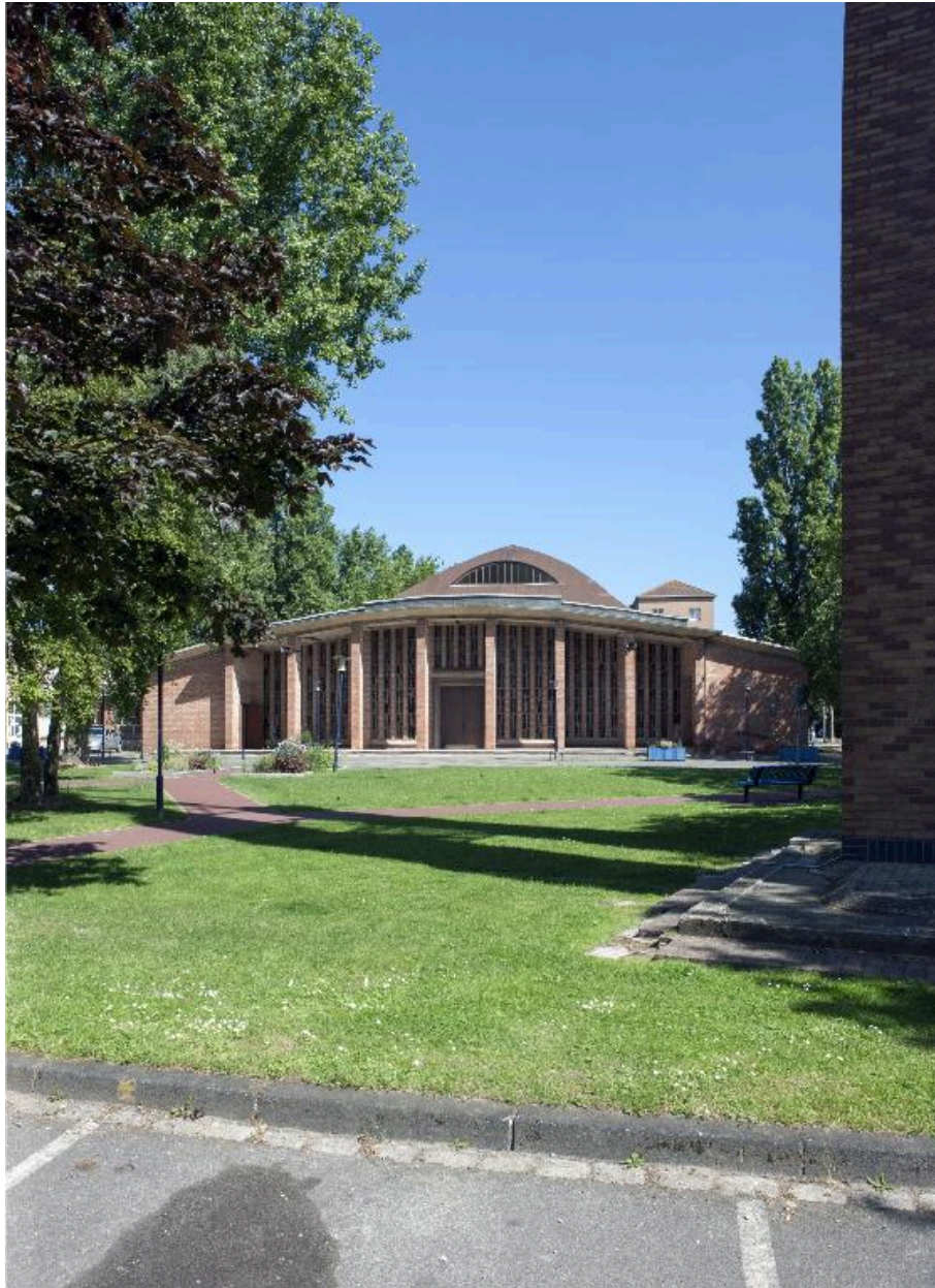
Élévation antérieure de l'église, depuis le clocher.
