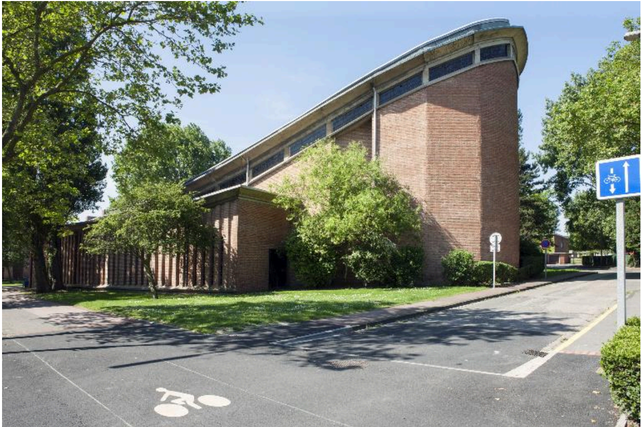
Élévation postérieure de l'église et flanc droit.
