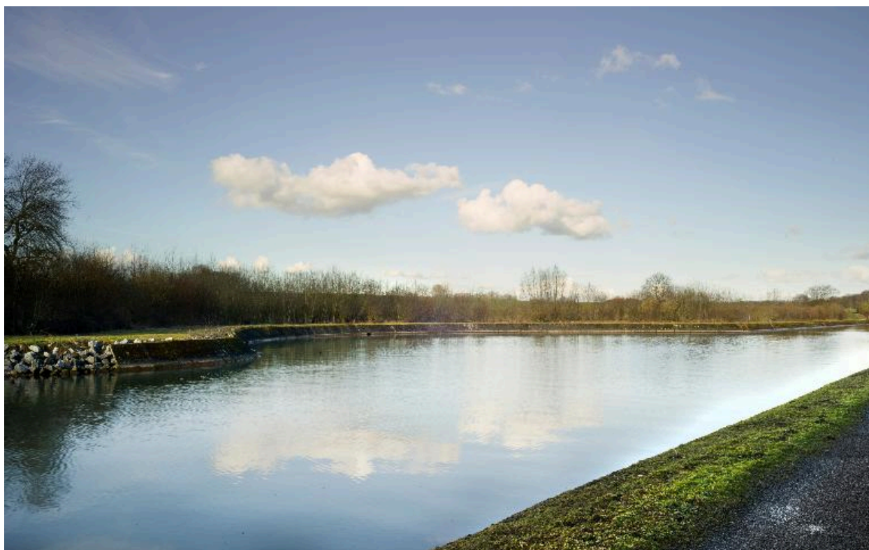
Hermies (Pas-de-Calais), aire de retournement ou de virement, vue générale depuis le chemin de halage, vers l'amont.
