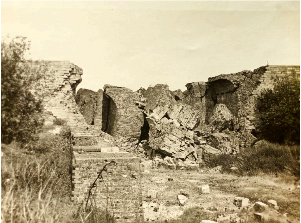
Canal du Nord. Guerre de 1914-1918. Moislains (Somme), écluse n°9 détruite. Vue de la tête aval (Musée de la batellerie et des voies navigables, Conflans-Sainte-Honorine).
