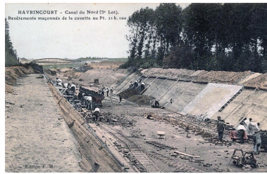
Chantier du canal du Nord. Travaux de revêtement de la cuvette maçonnée du canal à Havrincourt (Pas-de-Calais), entre 1908 et 1914 (collection particulière).
