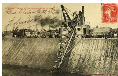
Chantier de construction du canal du Nord. Libermont (Oise). Excavateur et train de wagons, 1909 (Musée de la batellerie et des voies navigables, Conflans-Sainte-Honorine).
