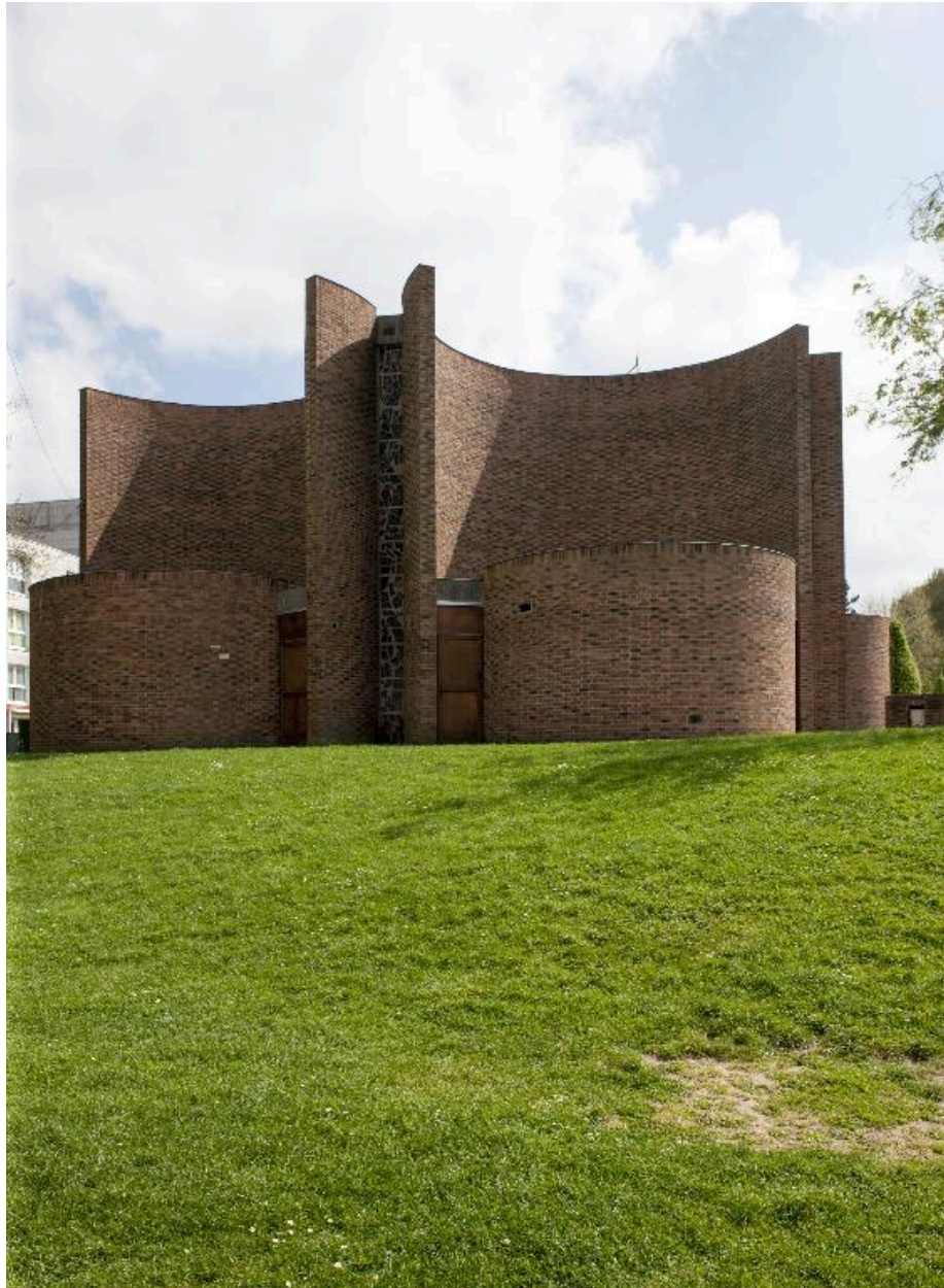
Élévation nord-ouest de l'église.
