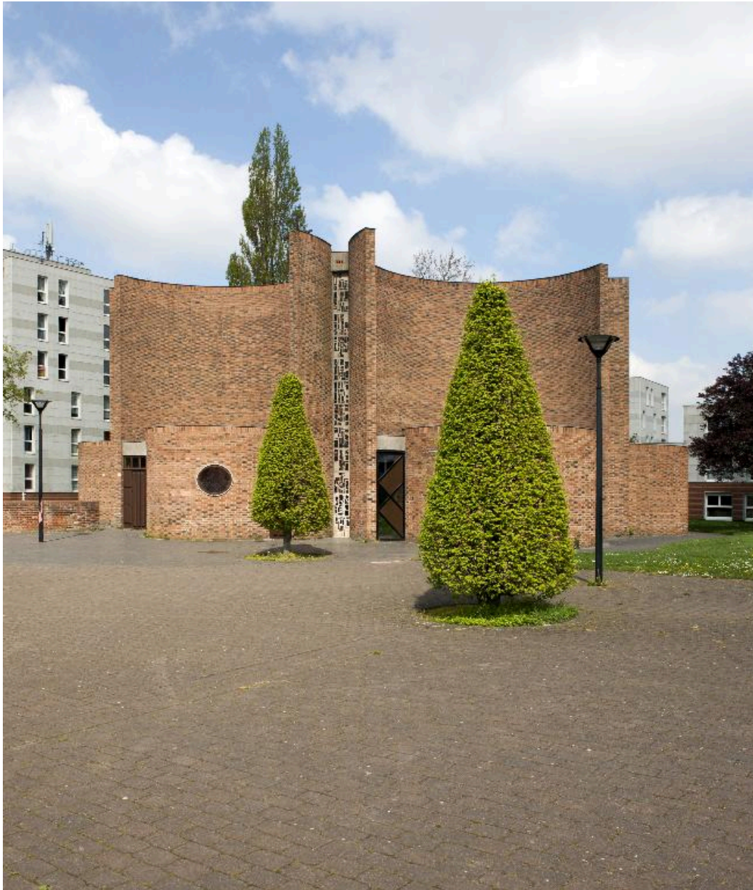
Élévation sud de l'église.
