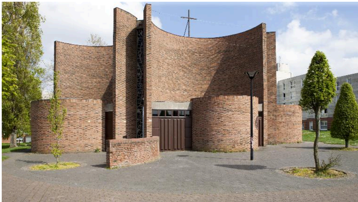
Élévation sud-ouest, avec l'entrée de l'église.
