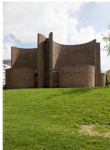
Élévation nord-ouest de l'église. Phot. Pierre Thibaut IVR31_20155900335NUCA
