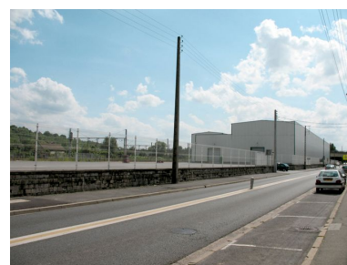
Vue générale du site en 2007. Phot. Clarisse Lorieux IVR22_20076005482NUCA
