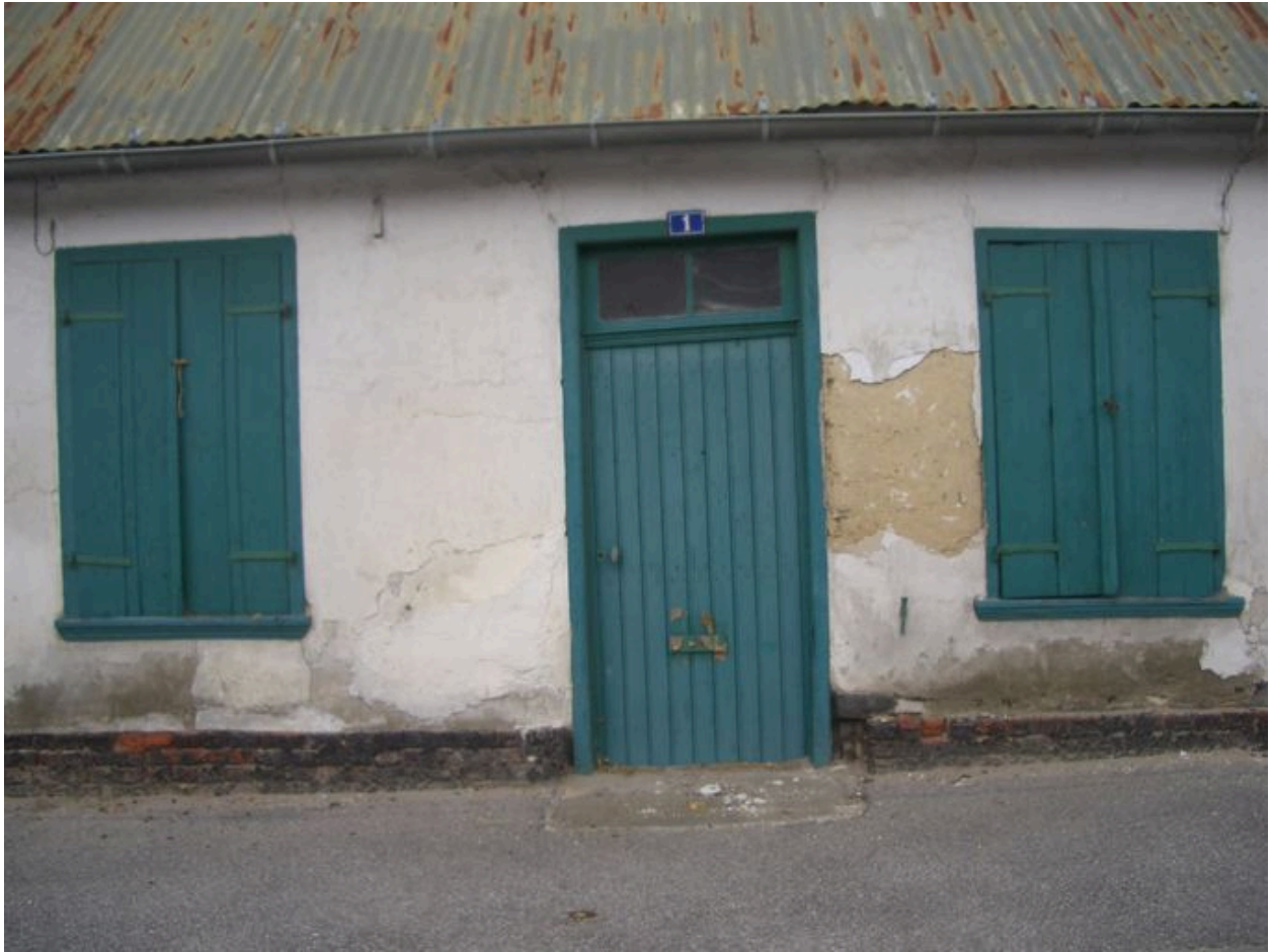
Détail des trois travées de la seconde partie habitable.
