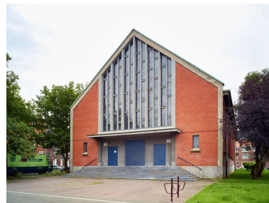
Élévation antérieure de l'église. Phot. Pierre Thibaut IVR31_20155901578NUCA
