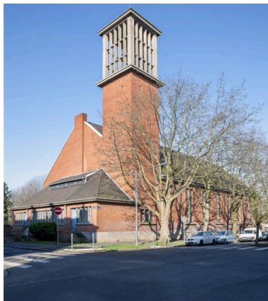
Élévation postérieure et flanc gauche. Phot. Pierre Thibaut IVR31_20155900642NUCA
