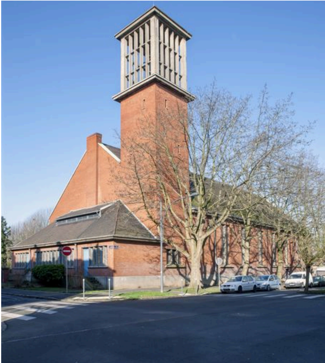
Élévation postérieure et flanc gauche.
