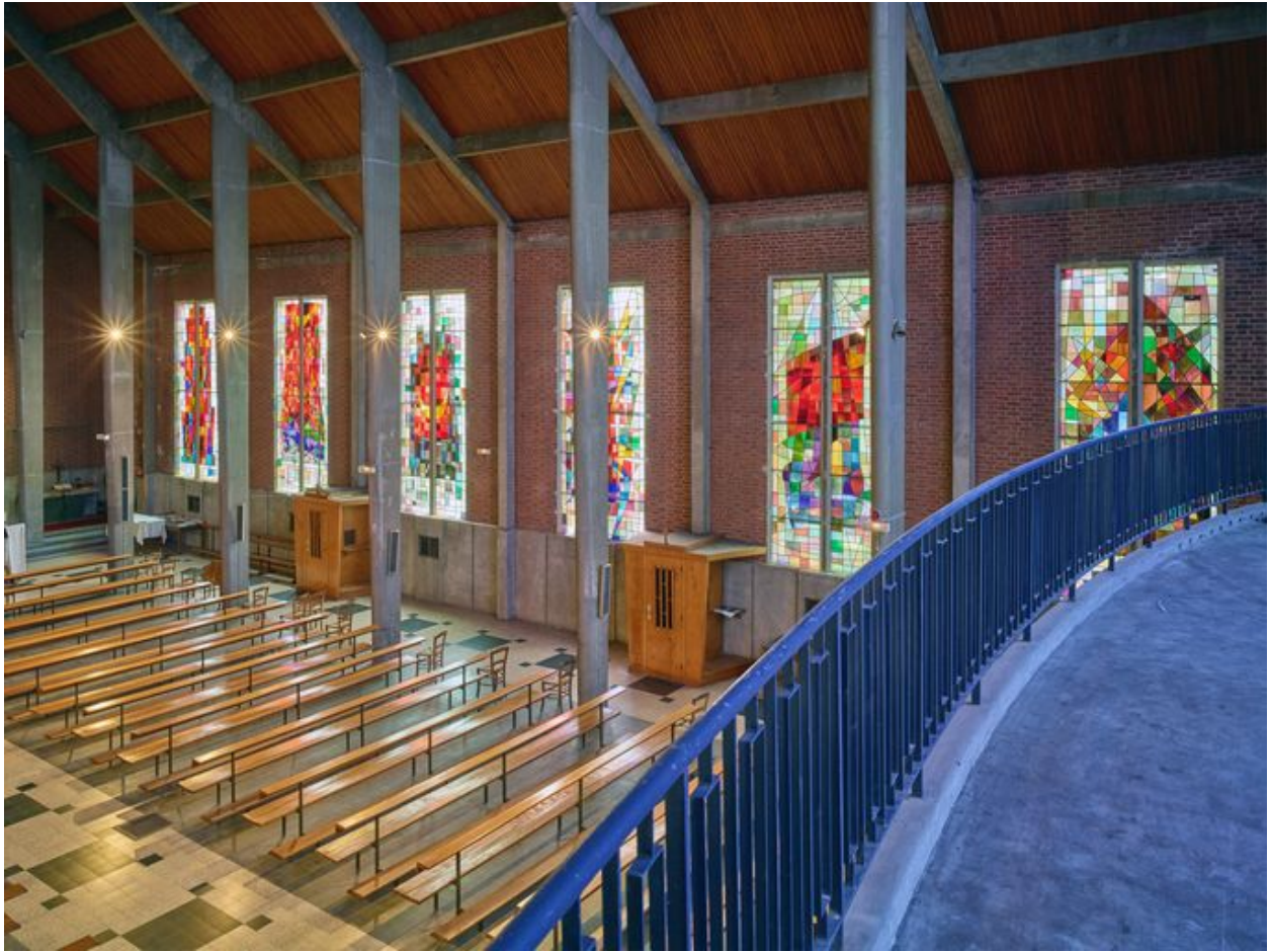
Vue du côté droit de la nef depuis la tribune d'orgue.
