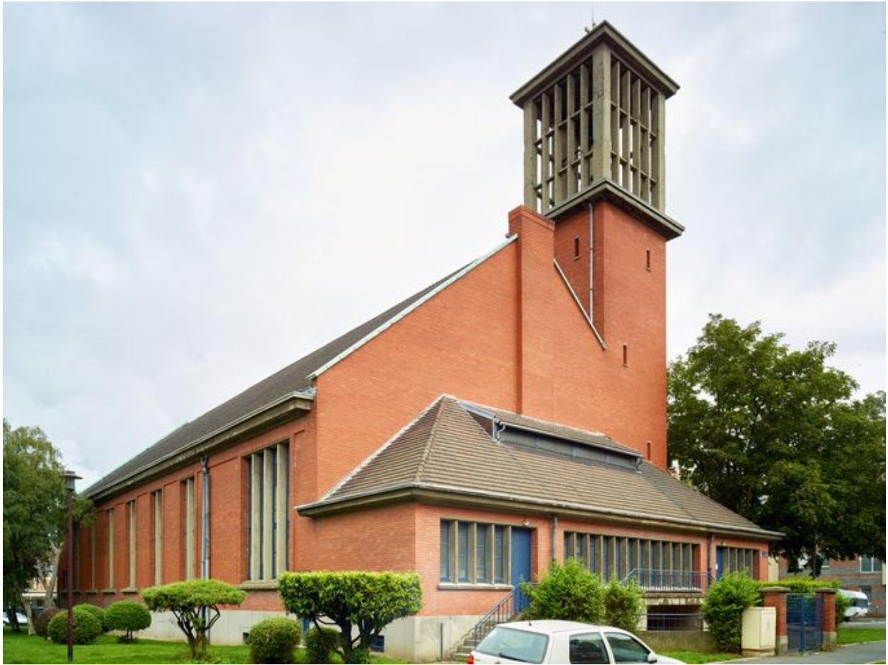
Élévation postérieure de l'église.
