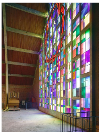
Vue de la verrière depuis la tribune d'orgue. Phot. Pierre Thibaut IVR31_20155901573NUCA
