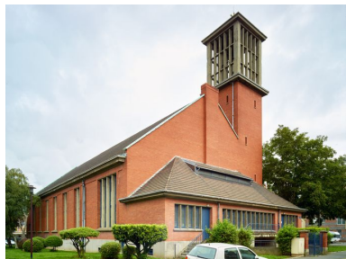
Élévation postérieure de l'église. Phot. Pierre Thibaut IVR31_20155901579NUCA
