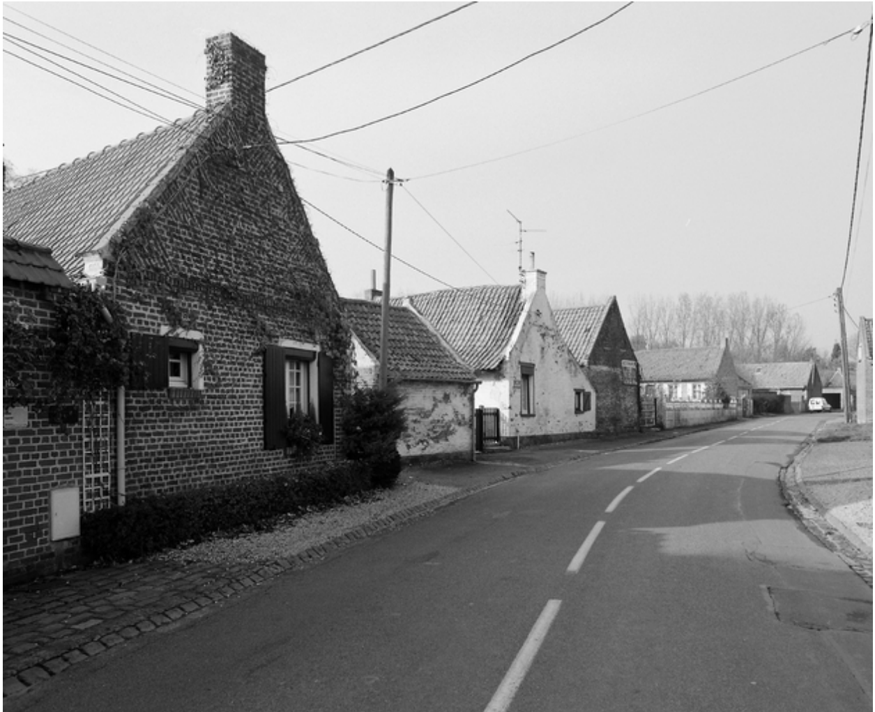
Alignement des fermes rue du Vieux-Condé.
