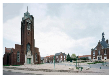
Vue de situation. Phot. Thierry Lefébure IVR22_20068000130PA
