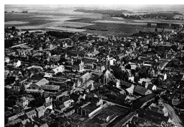
Vue aérienne (AD Somme ; 8 Fi 1845). Phot. Gilles-Henri Bailly (reproduction) IVR22_20158005789NUCA
