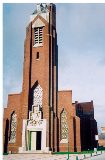
Vue générale. Phot. Gilles-Henri Bailly IVR22_20158005792NUCA
