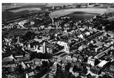
Vue aérienne (AD Somme ; 8 Fi 1846). Phot. Gilles-Henri Bailly (reproduction) IVR22_20158005790NUCA
