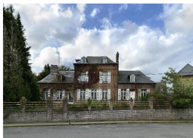
Vue générale depuis la place de l'Eglise. Phot. Thierry Lefébure IVR22_20148000645NUC2A
