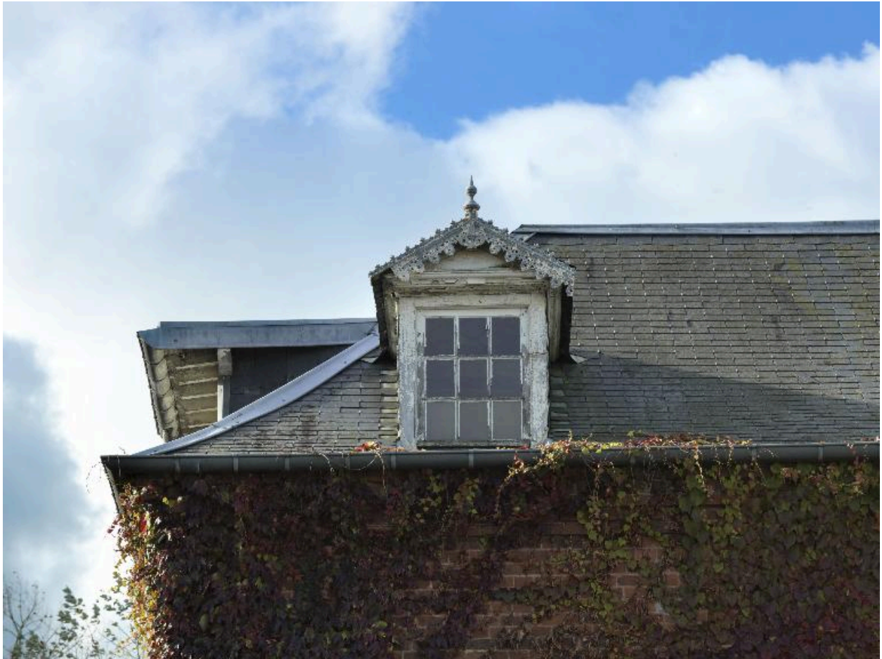
Lambrequin de la lucarne du toit.
