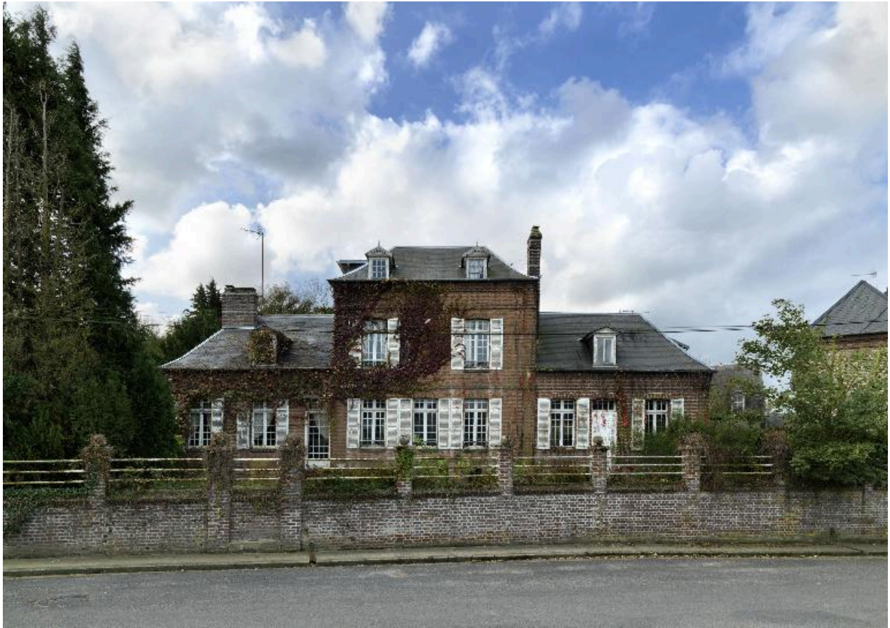
Vue générale depuis la place de l'Eglise.
