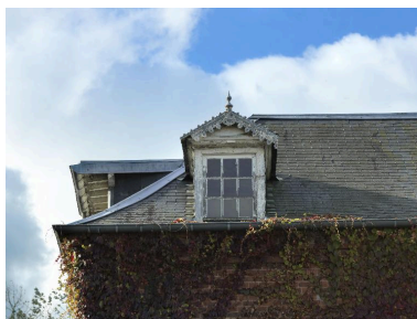
Lambrequin de la lucarne du toit. Phot. Thierry Lefébure IVR22_20148000646NUC2A
