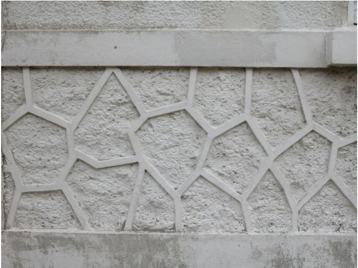
Détail du faux appareil du rez-de-chaussée.
