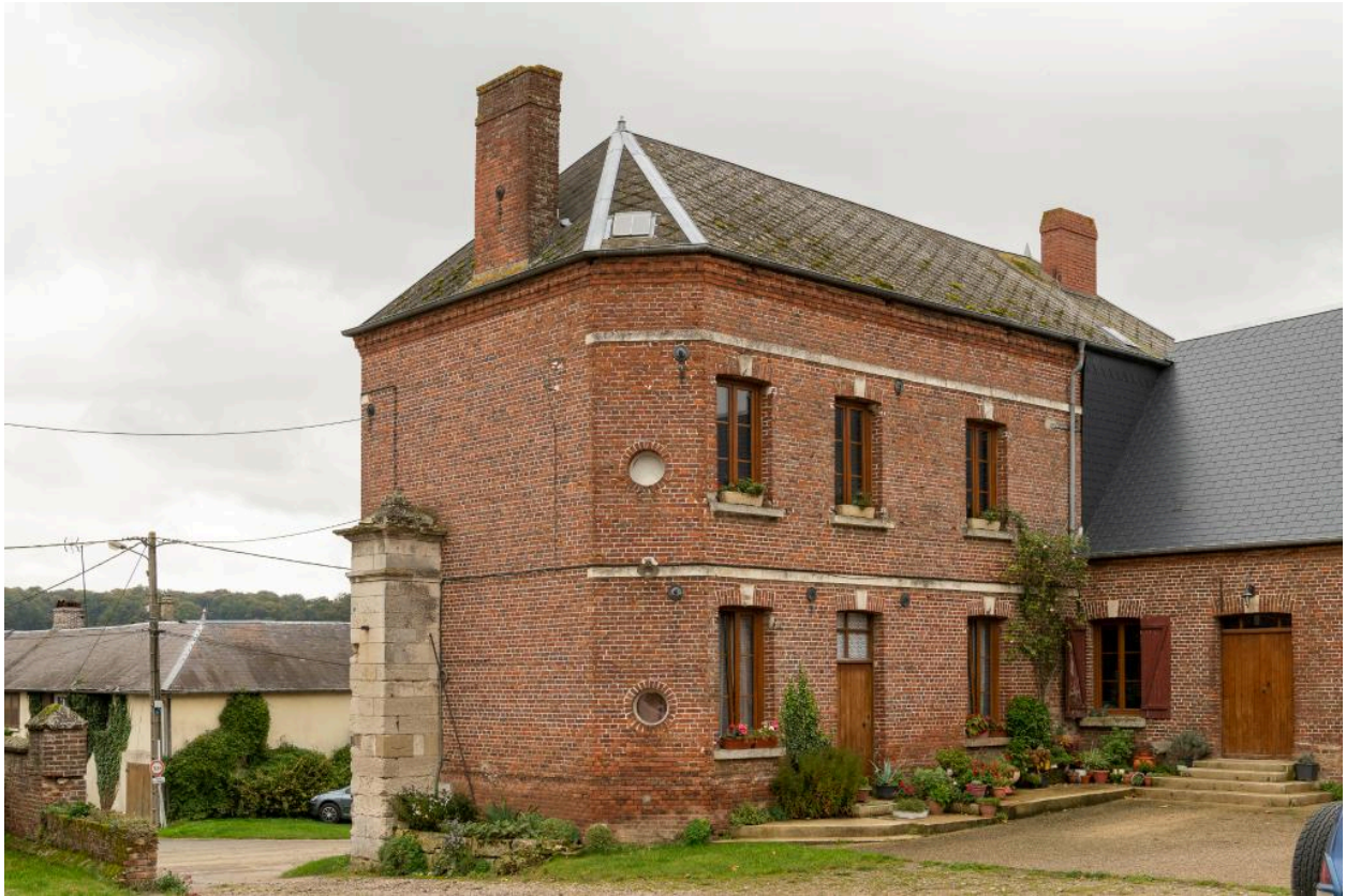
Vue depuis le nord-ouest de l'extension en brique du logis.
