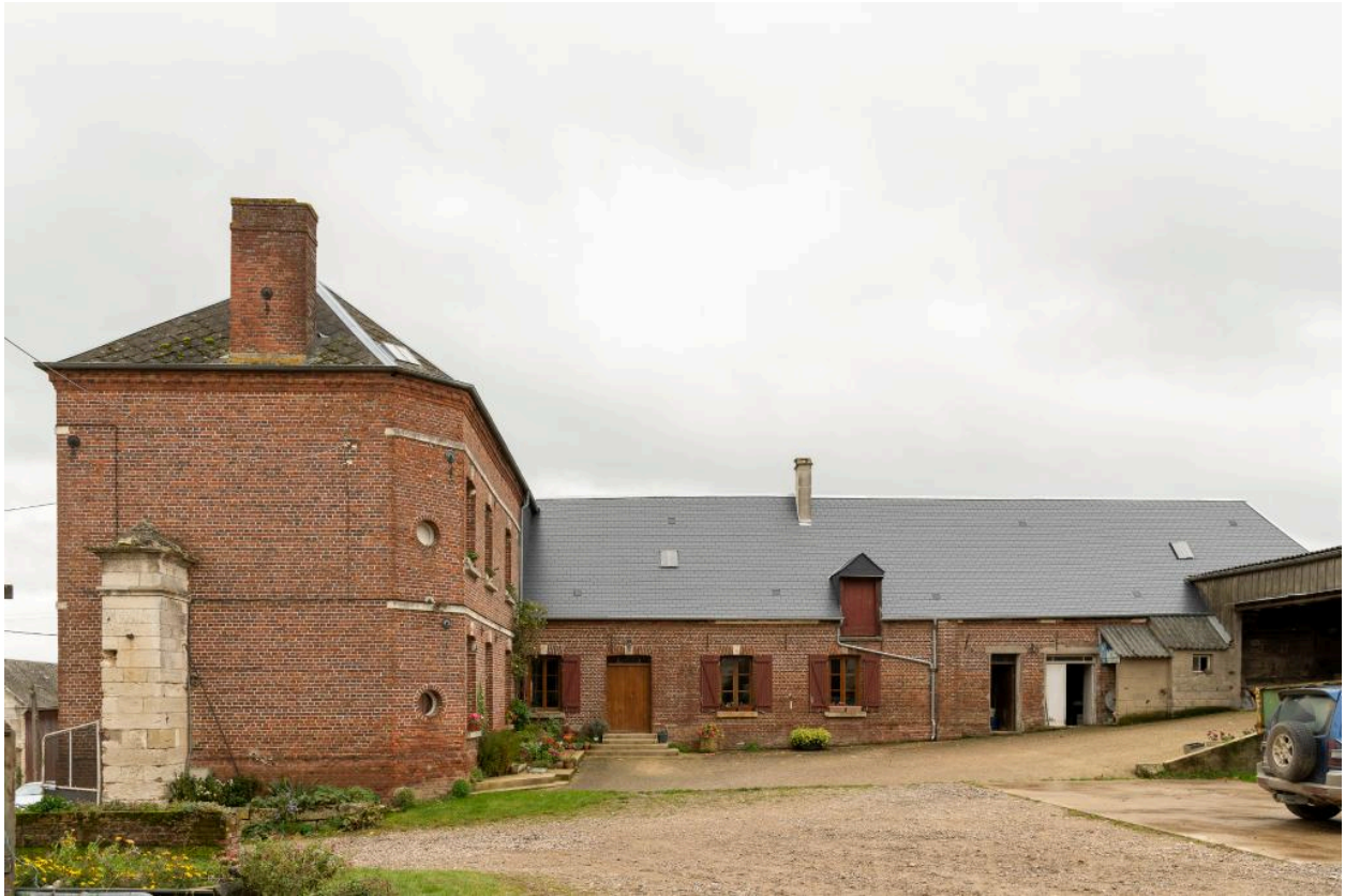
Vue générale du logis depuis le nord.
