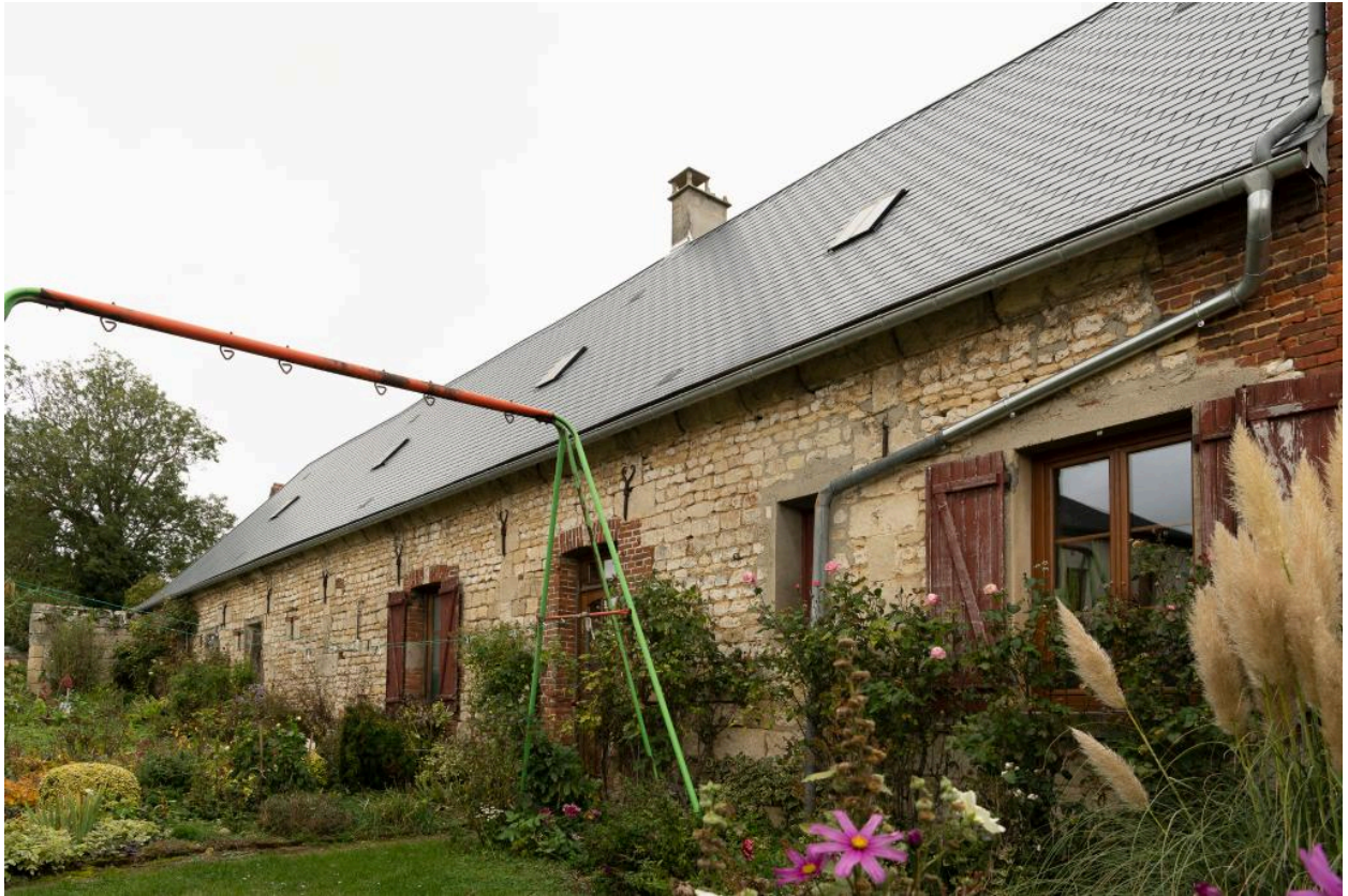
Vue depuis le sud-est de la partie ancienne du logis, 2e moitié du 18e siècle.
