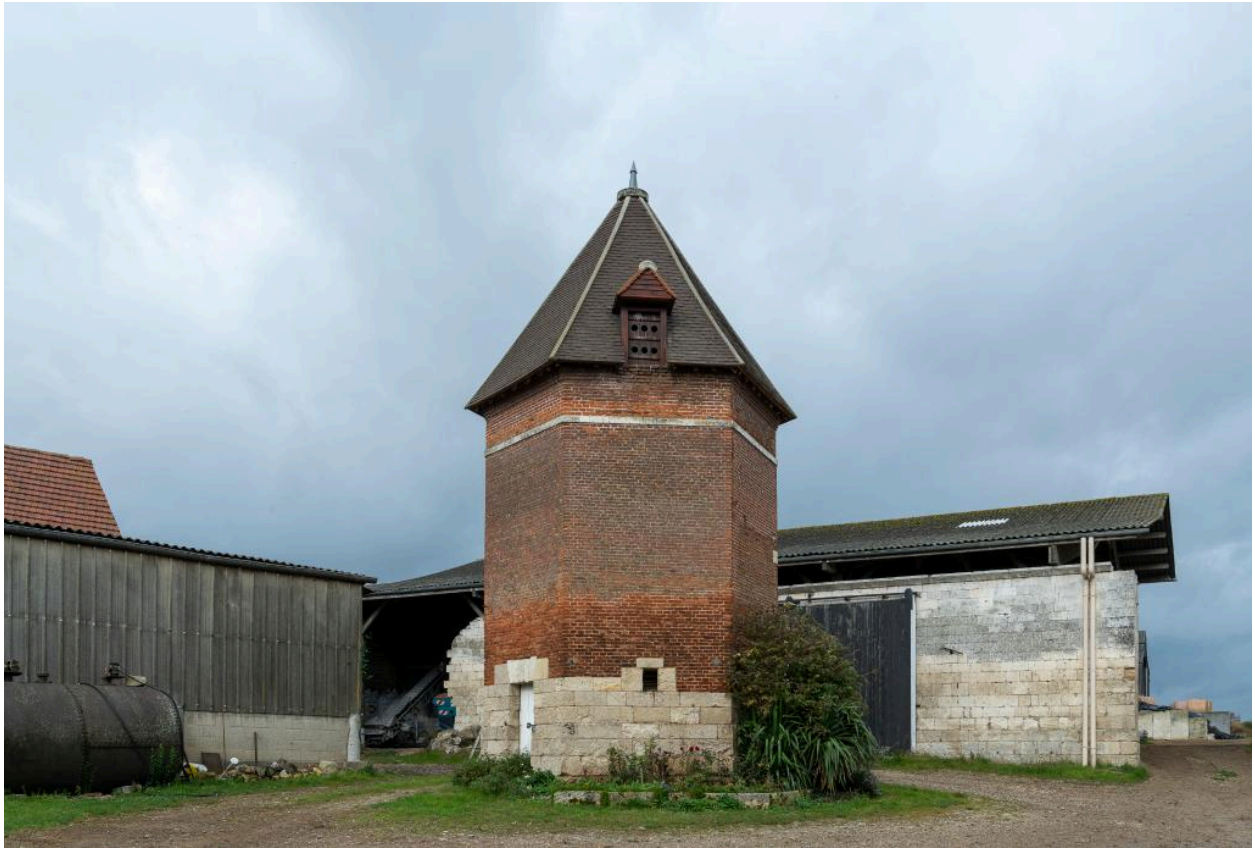
Vue générale depuis le sud du colombier et de l'ancienne grange.
