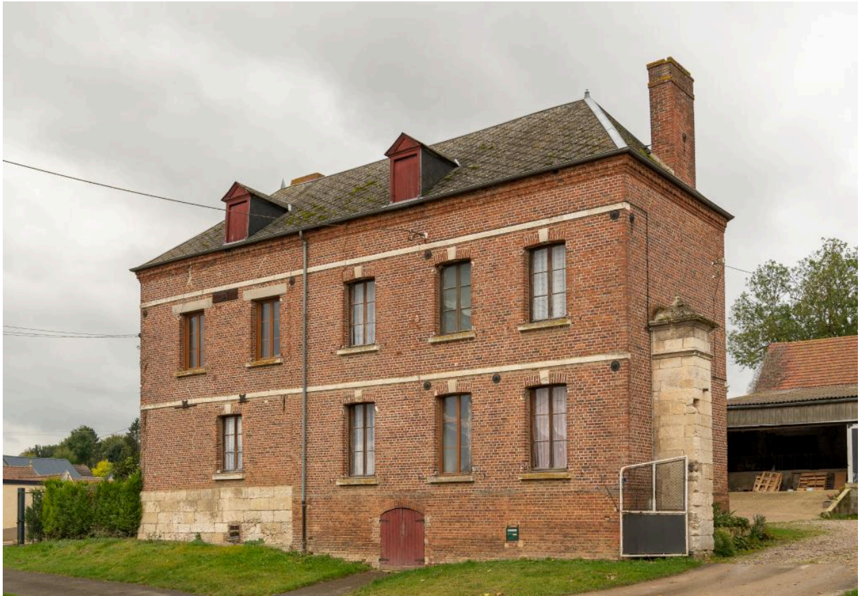
Vue depuis le nord-est de l'extension en brique du logis, premier tiers du 19e siècle.
