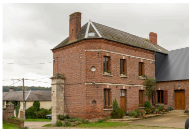
Vue depuis le nord-ouest de l'extension en brique du logis. Phot. Marc Kérignard IVR32_20216001247NUCA
