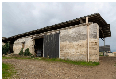
Vue depuis le sud-est de l'ancienne grange de la ferme du château, en pierre et en pans de bois et torchis, 18e siècle (?) Phot. Marc Kérignard IVR32_20216001239NUCA
