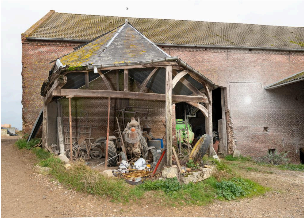
Ancien manège mécanique de la batteuse.
