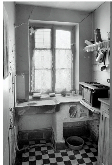
Vue de la cuisine, avec son évier en pierre bleue et sa gazinière "Elpes / Paris". Phot. Pierre-Yves Brest IVR22_19990202891Z
