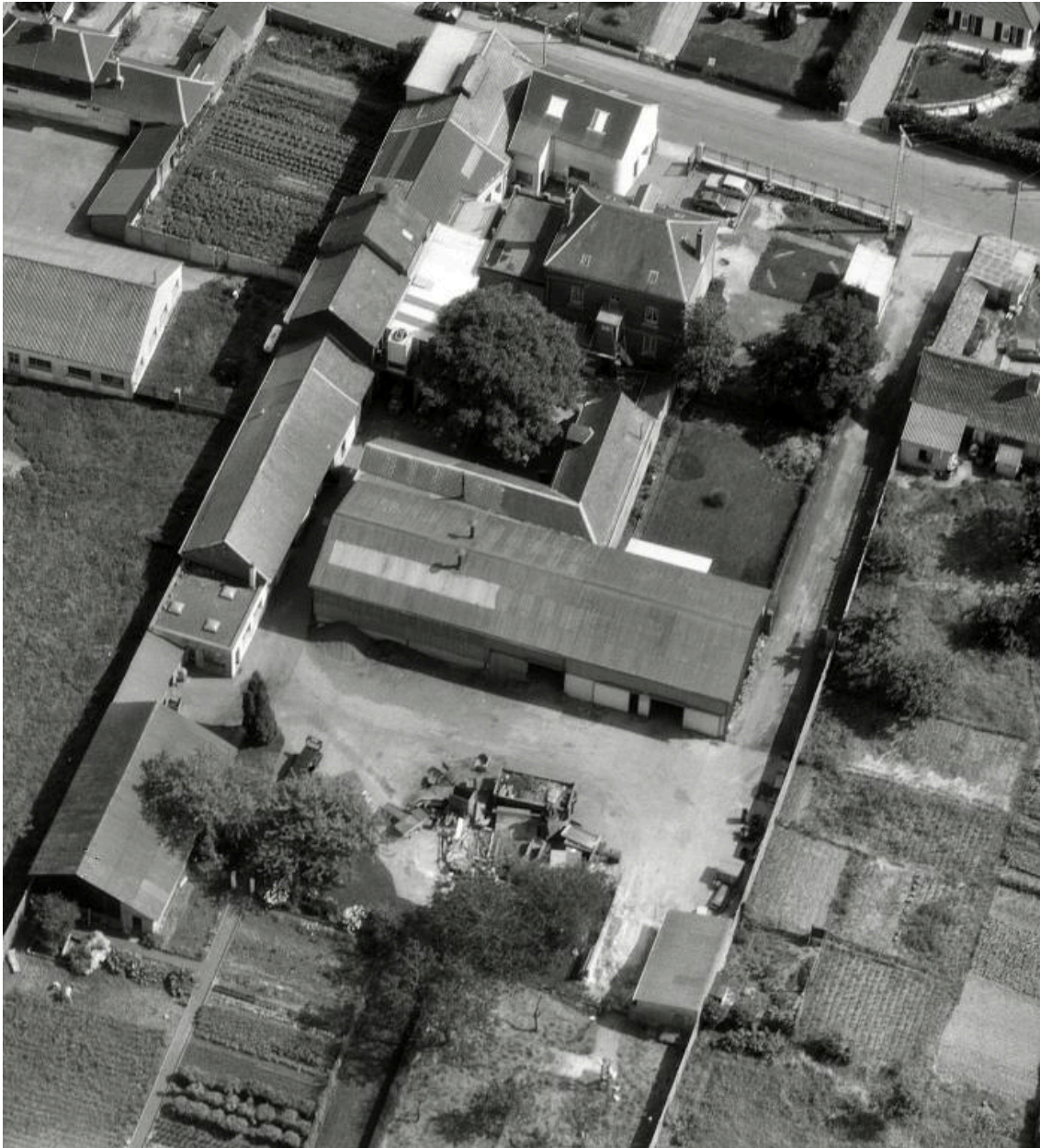
Vue aérienne, flanc nord, 1988.
