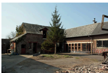
Anciens bâtiments de production. Phot. Frédéric-Nicolas Kocourek IVR22_20158005414NUCA
