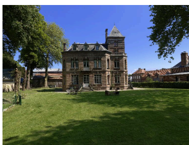
Façade postérieure. Phot. Thierry Lefébure IVR22_20158000366NUC2A
