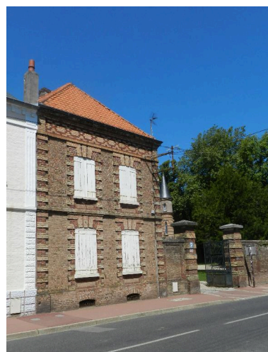
Les communs et le portail. Phot. Romain Grimaud IVR22_20128015616NUC1A
