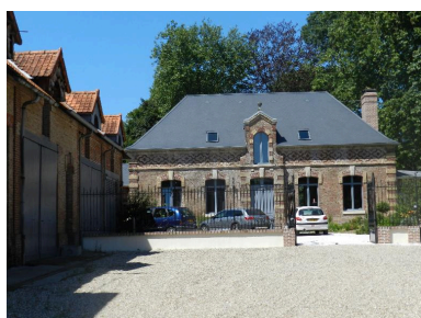
Les communs. Phot. Romain Grimaud IVR22_20128015617NUC1A
