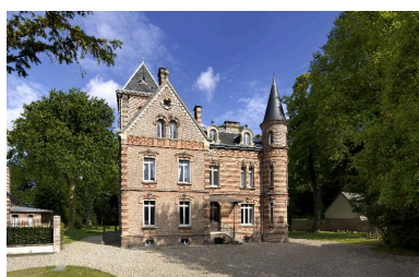
Façade antérieure. Phot. Thierry Lefébure IVR22_20158000551NUC2A
