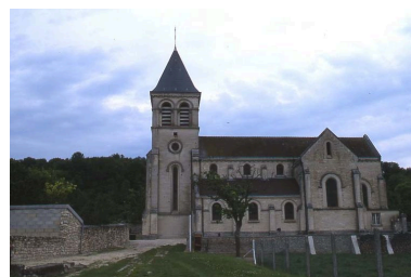
Vue latérale de l'édifice. Phot. Inès Guérin IVR22_20030203257NUCA
