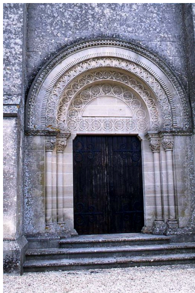
Vue détaillée du portail. Phot. Inès Guérin IVR22_20030203262NUCA
