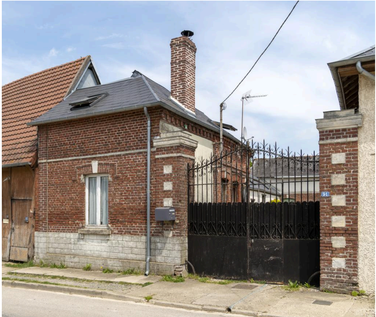
Ancienne fabrique de boutons de nacre, n°91 rue Principale, vue de la rue depuis l'ouest.
