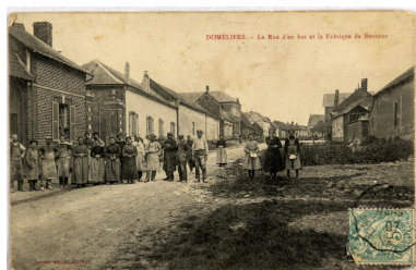
Vue depuis le nord de la rue d'En Bas et de la fabrique de boutons de nacre (actuellement n°91 rue d'En Bas). Carte postale du 1er quart du 20e siècle (coll. part.). Phot. Marc Kérignard IVR32_20216000381NUCA
