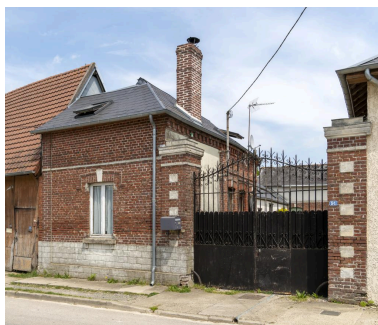
Ancienne fabrique de boutons de nacre, n°91 rue Principale, vue de la rue depuis l'ouest. Phot. Marc Kérignard IVR32_20216000524NUCA
