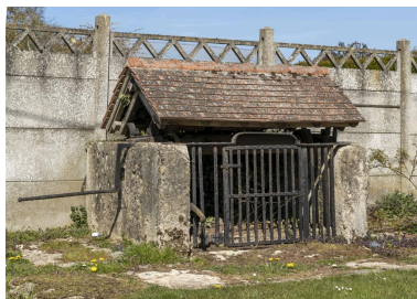
Ancien puits sous la forme d'un édicule architecturé (a certainement perdu son toit fait de deux blocs de calcaire), rue Principale en face de la mairie-école.
