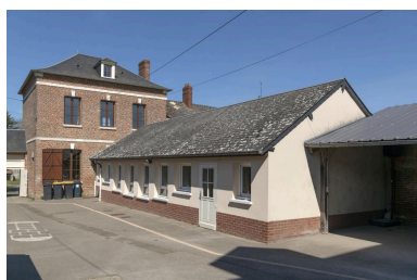
Cour de l'école avec nouveaux bâtiments et façade sud de la mairie-école. Phot. Marc Kérignard IVR32_20216000320NUCA
