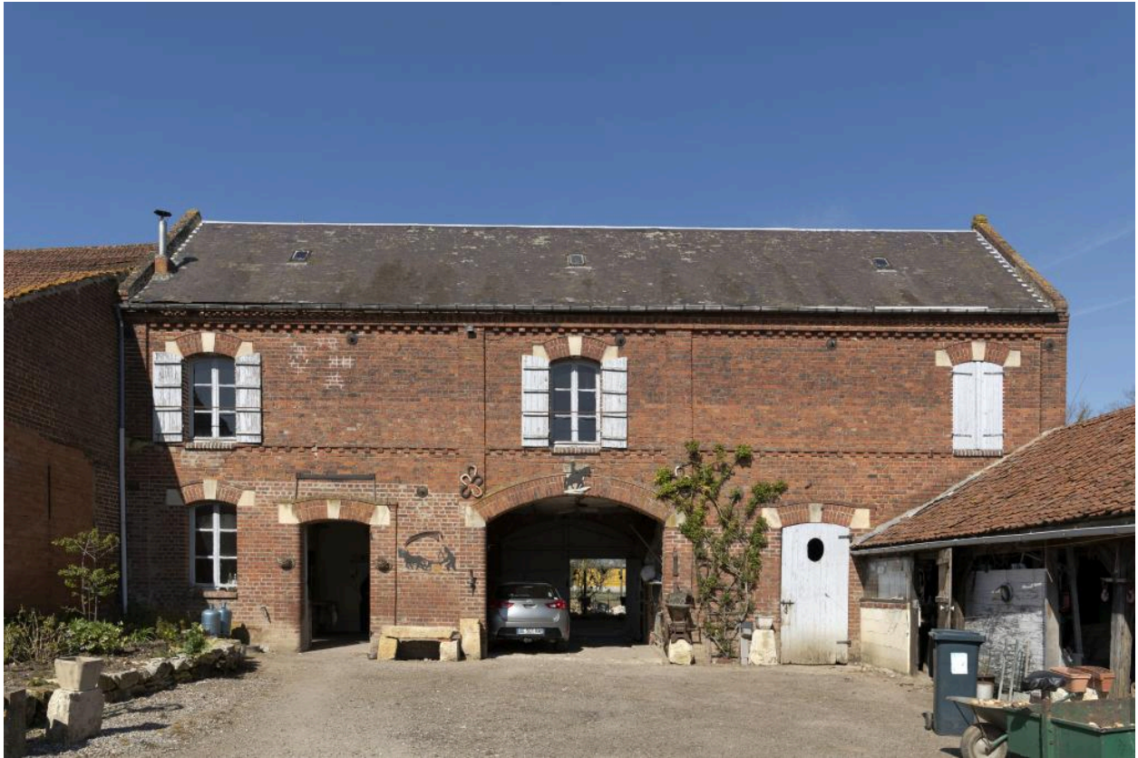
Ancien relais à chevaux (avec écuries au rez-de-chaussée) puis salle communale (1er étage), n°48 rue Principale, vue depuis l'est.
