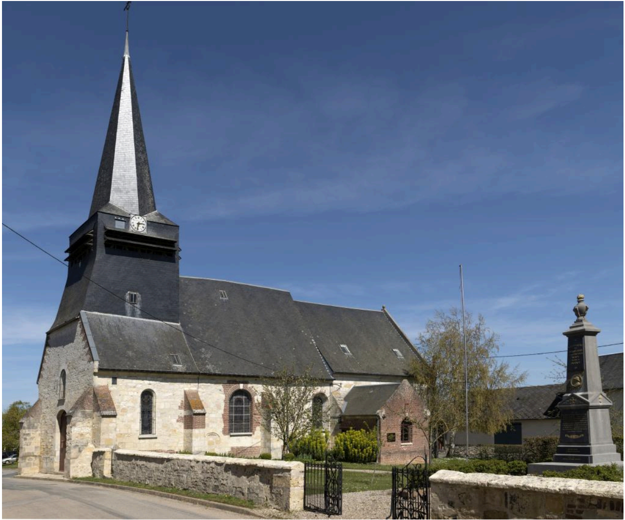
Vue de l'église et de l'ancienne clôture du cimetière avec le monument aux morts.
