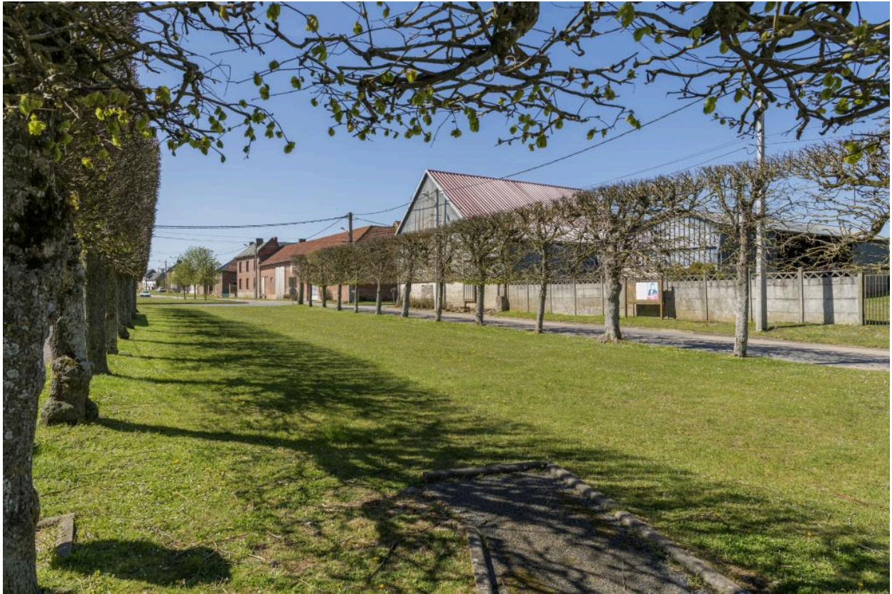
Place publique de Doméliers, rue Principale, vue depuis le nord.
