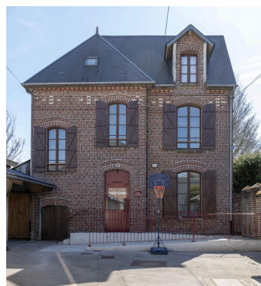
Ancien logement de l'instituteur, fond de cour de l'école, façade nord. Phot. Marc Kérignard IVR32_20216000322NUCA
