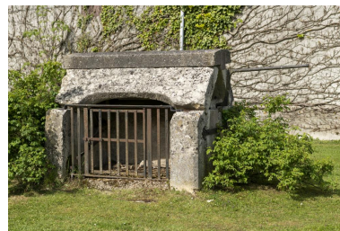
Ancien puits en forme d'édicule architecturé, blocs de calcaire, vers le n°4 rue Principale.
