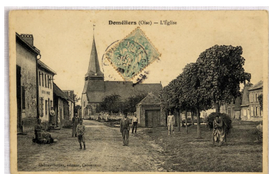
Vue depuis le sud de l'église, de la remise des pompes et d'une partie de la place publique. Carte postale du 1er quart du 20e siècle (coll. part). Phot. Marc Kérignard IVR32_20216000370NUCA
