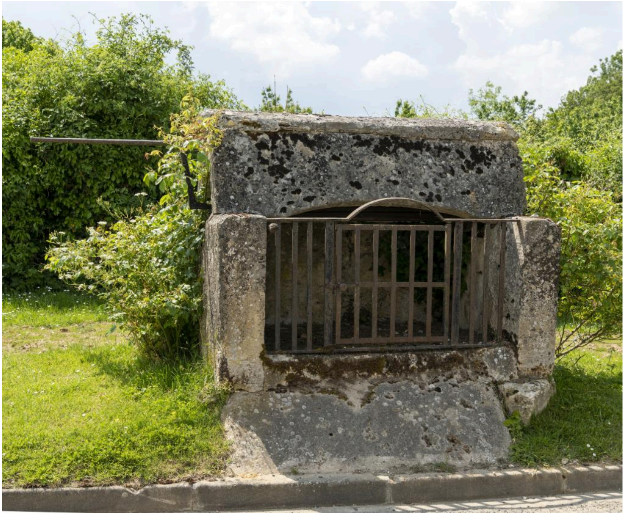
Ancien puits en forme d'édicule architecturé, blocs de calcaire, situé au niveau du n°15 rue d'En Bas.
