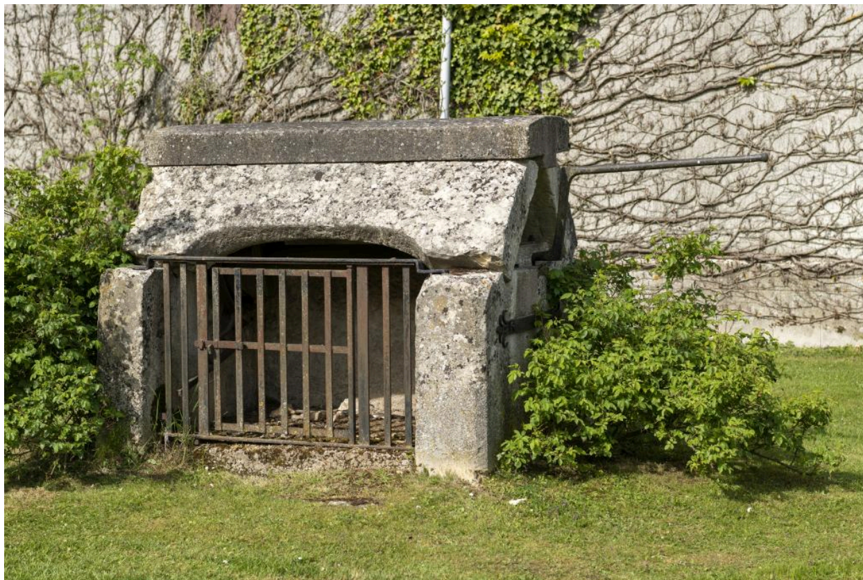
Ancien puits en forme d'édicule architecturé, blocs de calcaire, vers le n°4 rue Principale.
