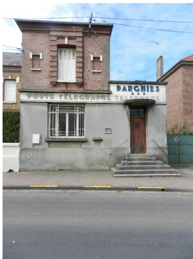
L'élévation principale. Phot. Romain Grimaud IVR22_20138015978NUC1A
