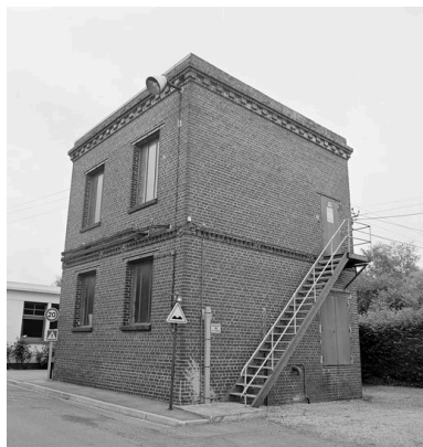
Transformateur. Phot. Olivier Coquelle
