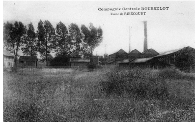
Vue générale (AP). Repro. Monnehay- Vulliet Marie-Laure IVR22_20106000509NUCA
