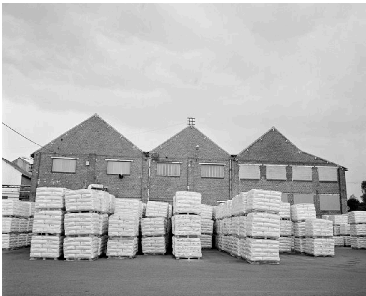
Atelier de fabrication et salle des machines.
