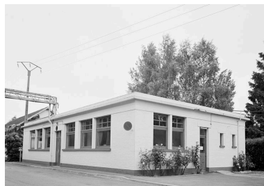
Bureaux. Phot. Olivier Coquelle IVR22_19946001176X
