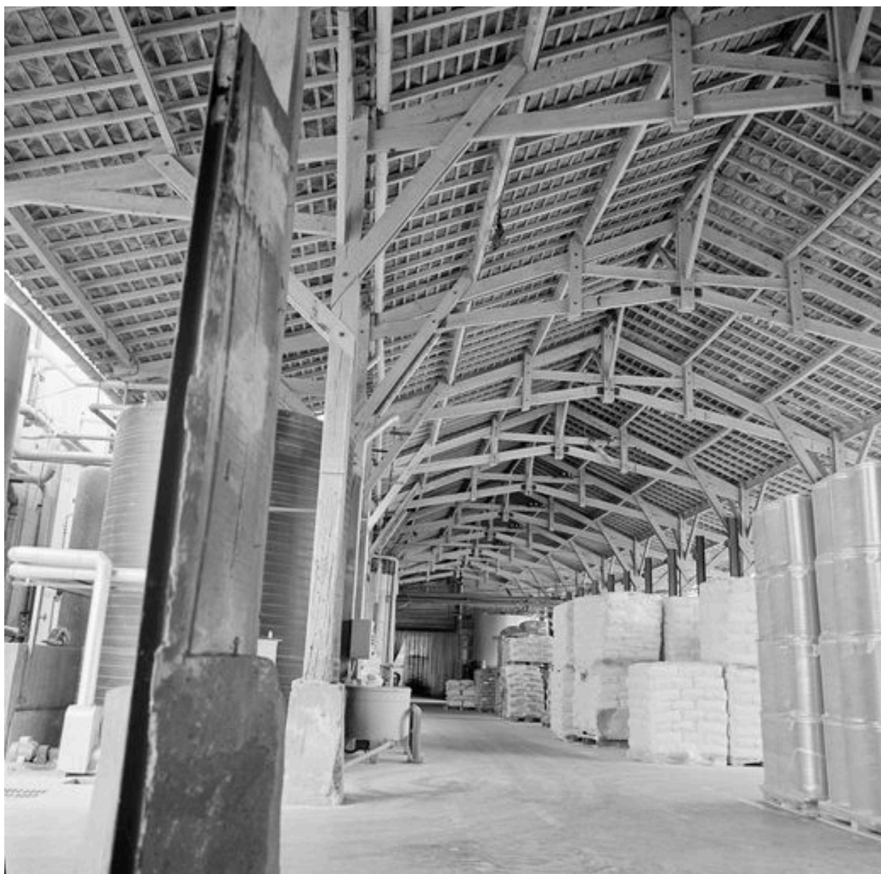
Magasin industriel : vue intérieure.
