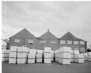
Atelier de fabrication et salle des machines. Phot. Olivier Coquelle IVR22_19946001172X
