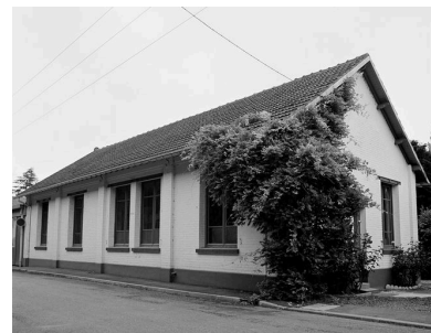
Bureaux. Phot. Olivier Coquelle IVR22_19946001177X
