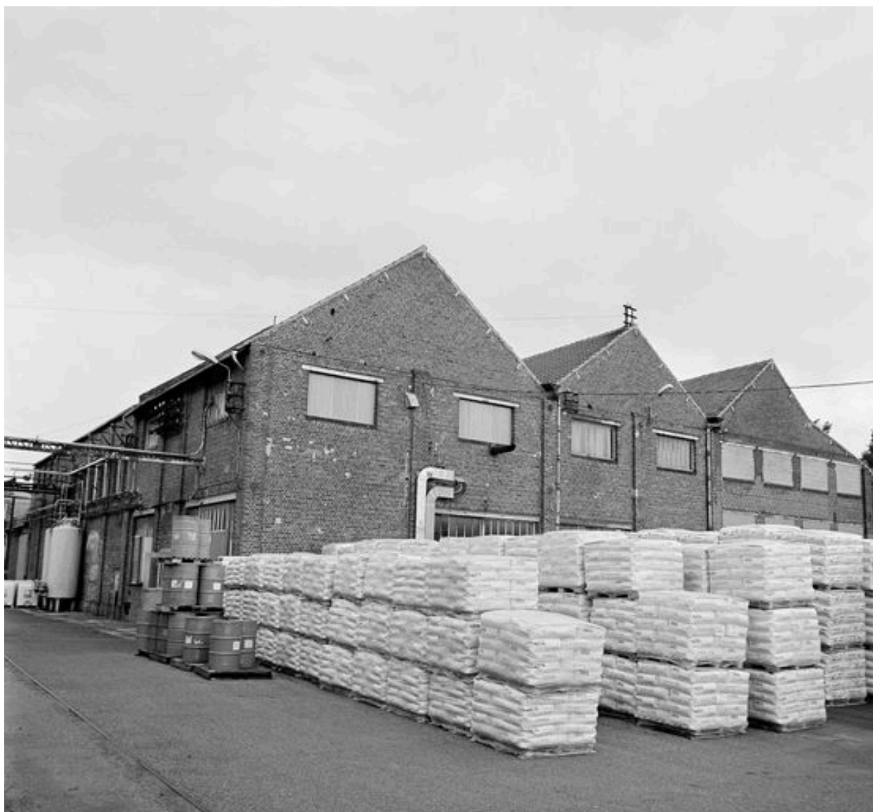
Atelier de fabrication et salle des machines.
