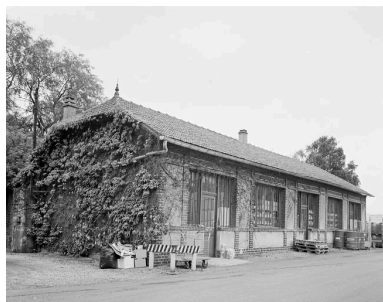
Cantine (ou remise ?). Phot. Olivier Coquelle IVR22_19946001175X
