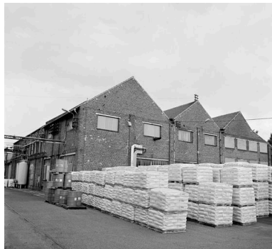
Atelier de fabrication et salle des machines. Phot. Olivier Coquelle IVR22_19946001171X
