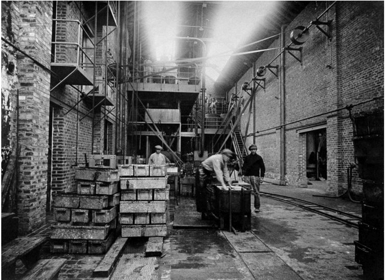
Atelier de fabrication : vue intérieure, vers 1950 (AP).
