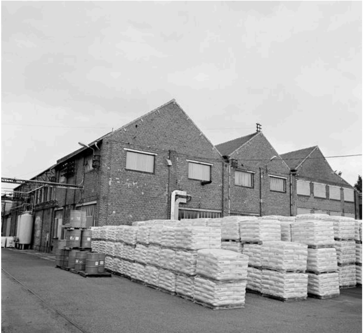
Atelier de fabrication et salle des machines.
