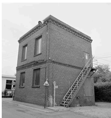
Transformateur. Phot. Olivier Coquelle
