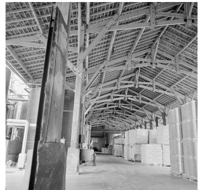
Magasin industriel : vue intérieure. Phot. Olivier Coquelle IVR22_19946001180X
