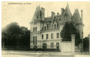
Façade antérieure du château Civet (collection particulière). Phot. Clarisse Lorieux IVR22_20106003165NUCAB
