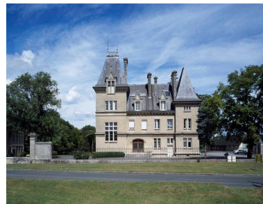
Vue générale du château Civet. Phot. Thierry Lefébure IVR22_20106000835VA
