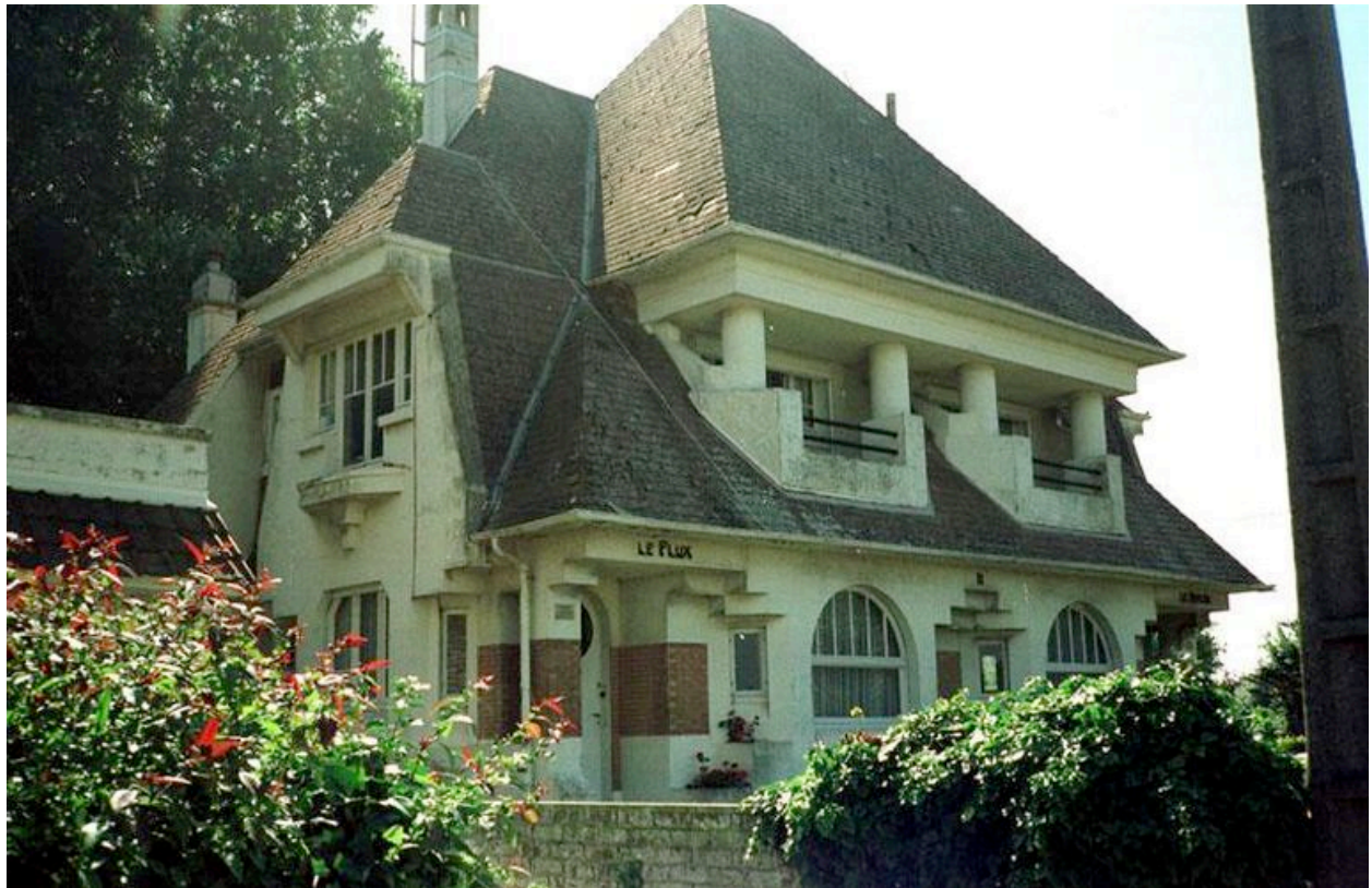
Le Flux. Vue générale depuis le nord.
