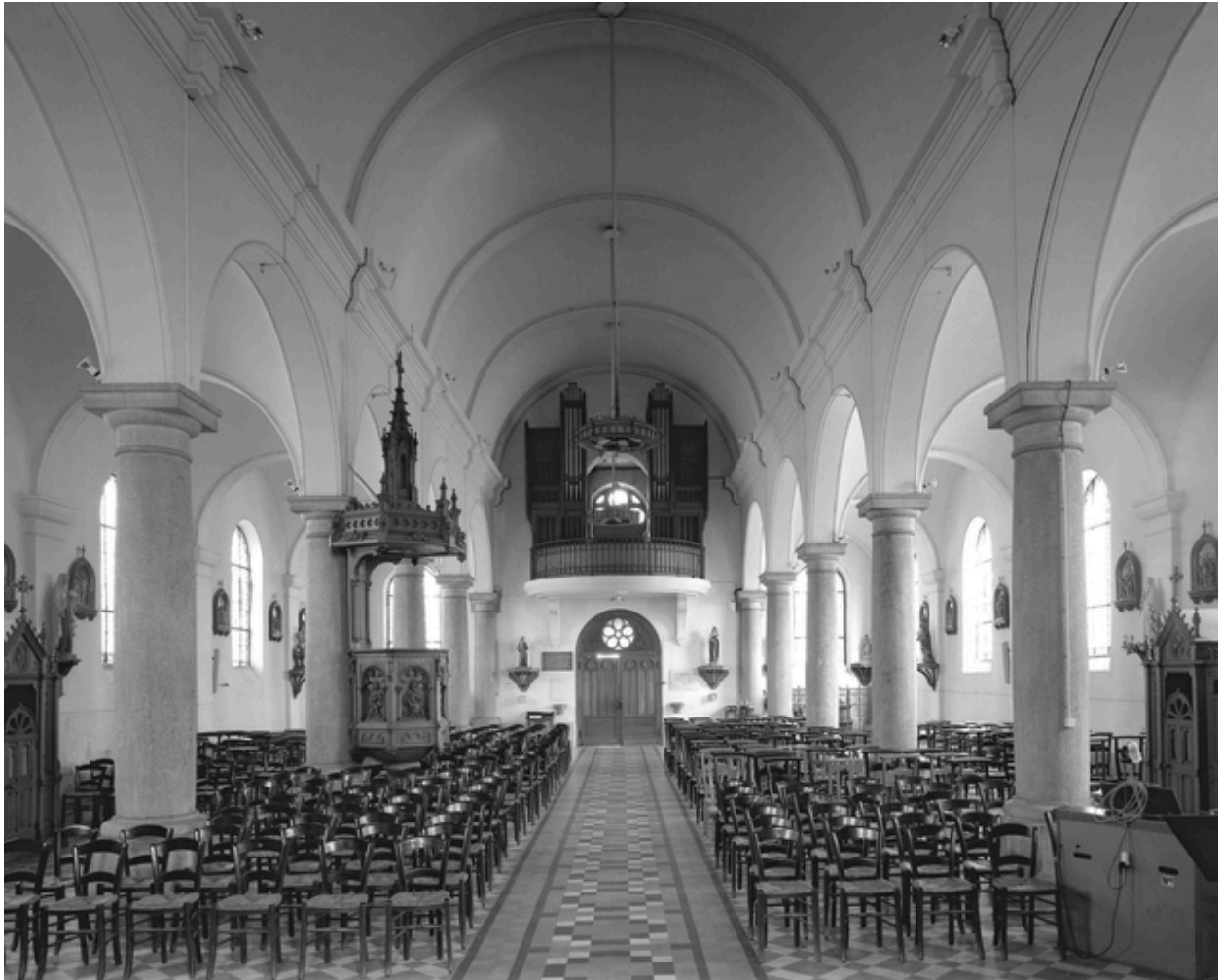
Vue générale intérieure vers l'entrée.
