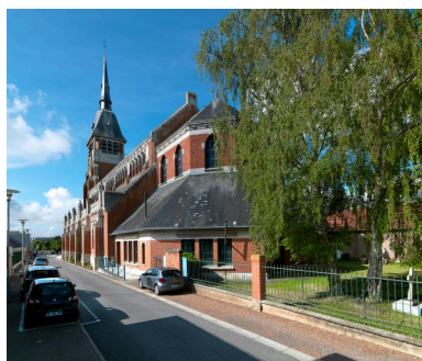
Vue générale depuis le nord-est. Phot. Thierry Lefébure IVR32_20208000111NUC2AQ
