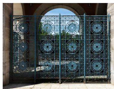
Vue de la grille du porche. Phot. Thierry Lefébure IVR32_20208000115NUC2A
