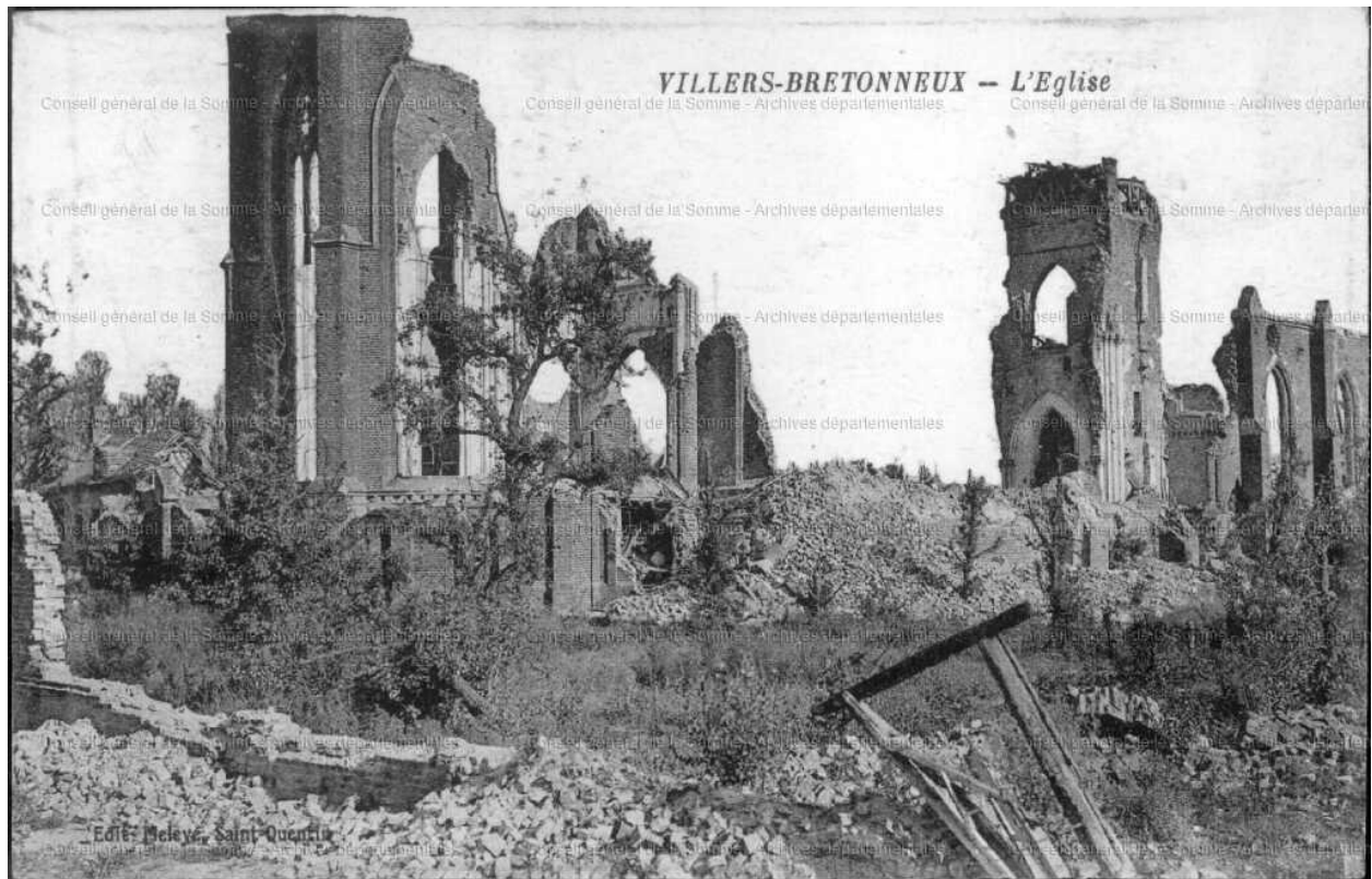
L'ancienne église en ruine (AD Somme ; 10R 1252).
