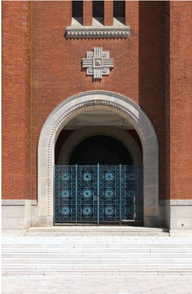
Vue du porche et de la grille, depuis le sud.
