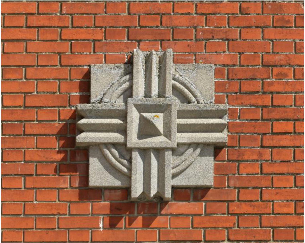
Vue de détail sur le décor en ciment moulé.
