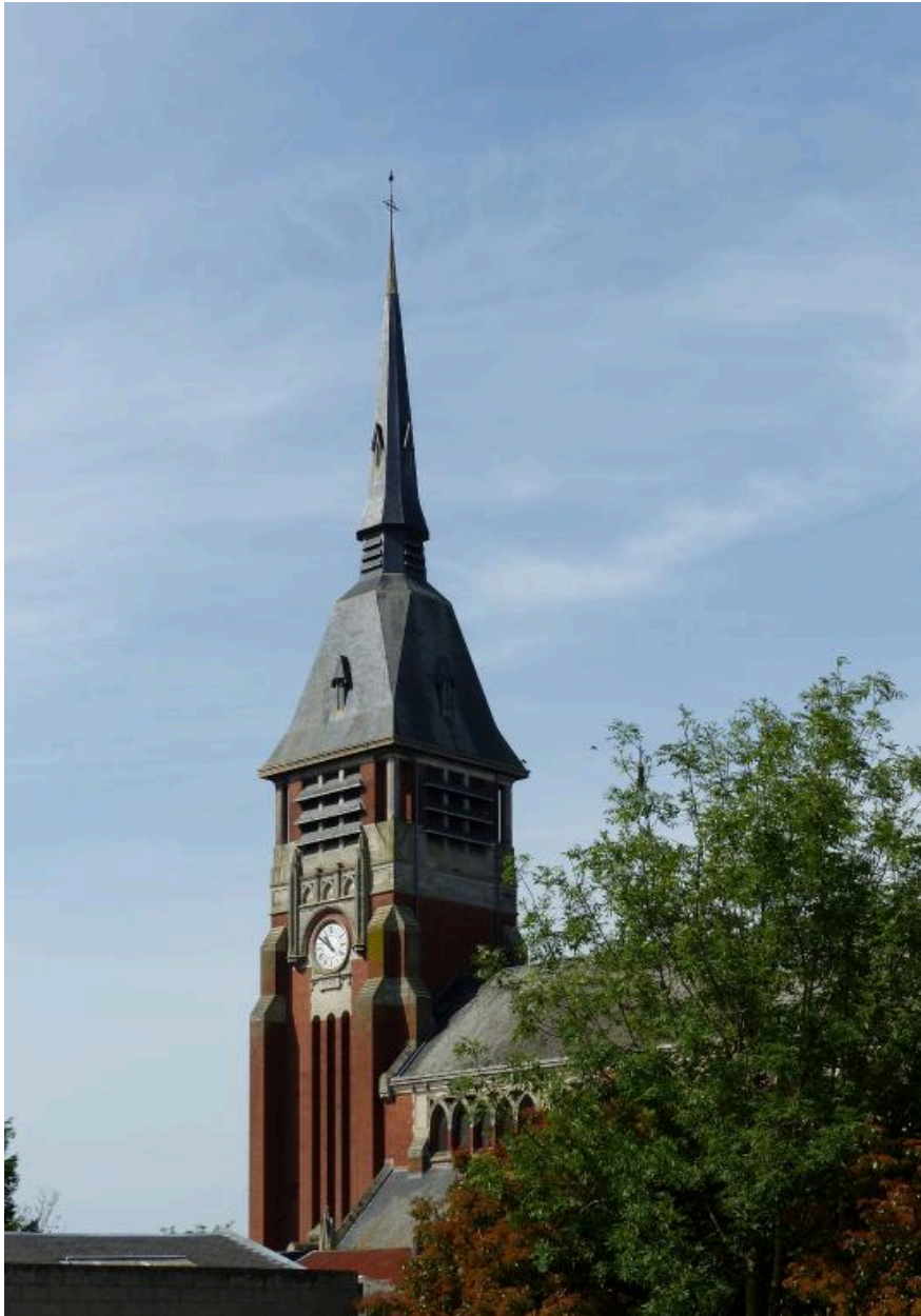
Le clocher de l'église, vue de situation depuis le nord-est.
