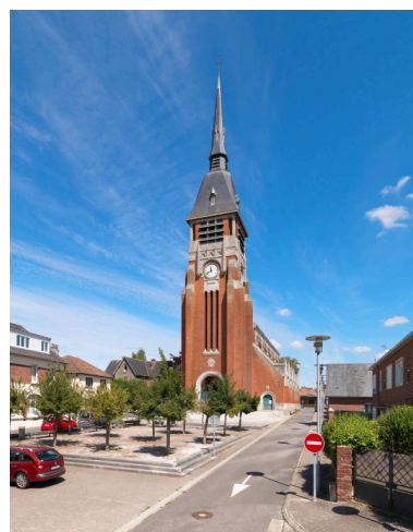
Vue de situation depuis le sud-est. Phot. Thierry Lefébure IVR32_20208000110NUC2AQ
