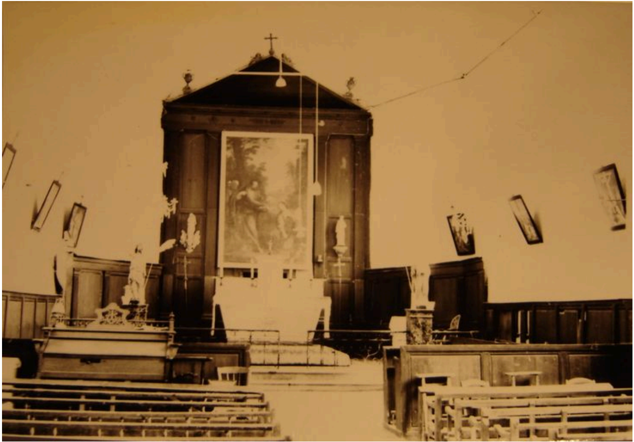
Vue du choeur de l'église au début du 20e siècle.
