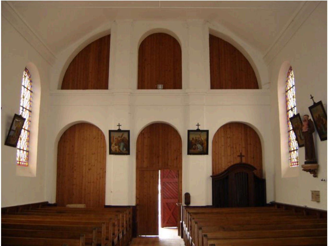
Vue intérieure du mur ouest.
