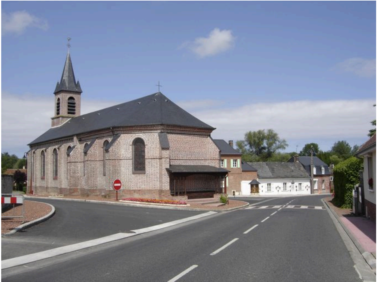
Vue générale depuis l'est.
