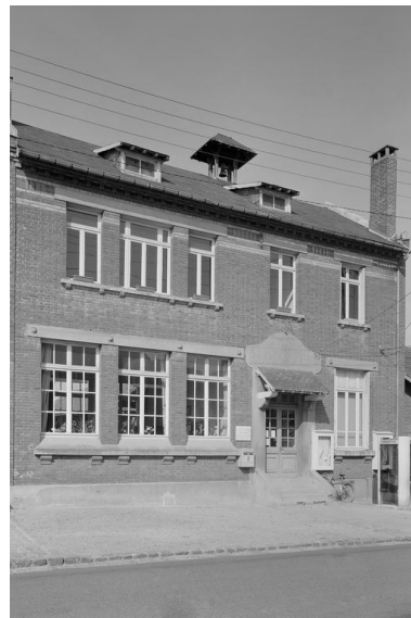
Elévation antérieure. Phot. Jean-Michel Perrin IVR22_19856000575X
