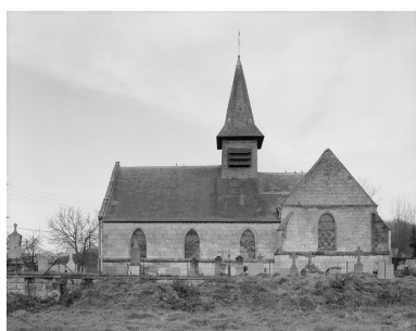
Élévation sud. Phot. Jean-Michel Perrin IVR22_19846001405V
