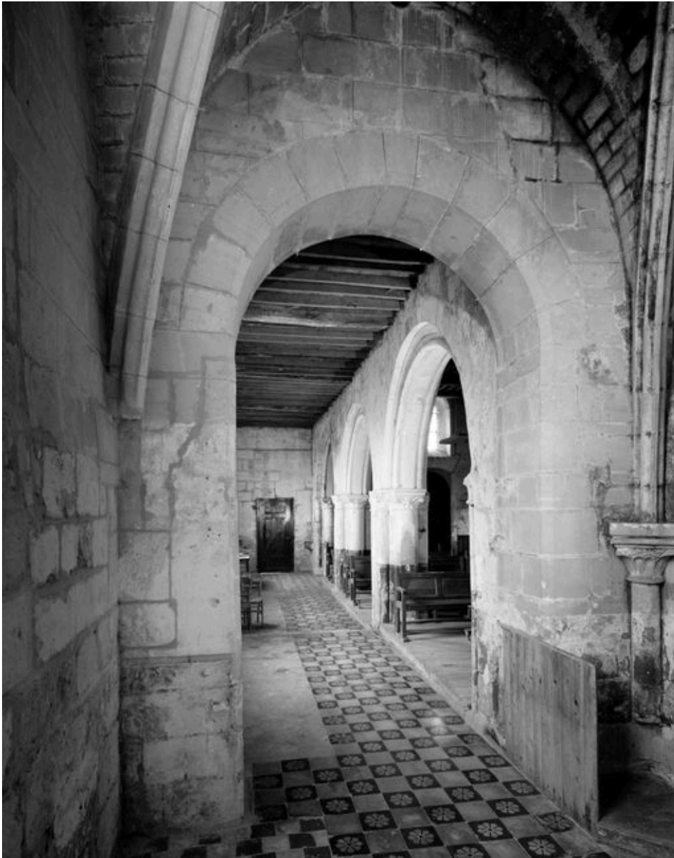
Vue intérieure du bas-côté sud d'est en ouest.
