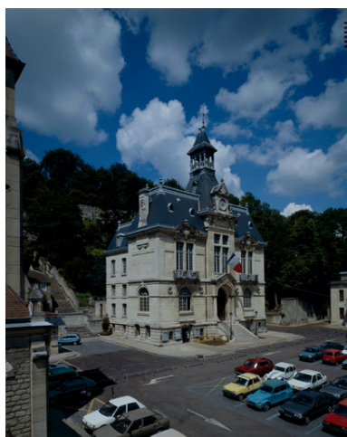
Vue d'ensemble depuis le toit du marché couvert. Phot. Thierry Lefébure IVR22_19900201393VA
