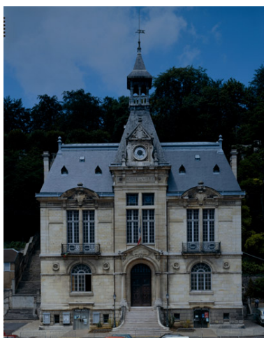
Élévation de la façade. Phot. Thierry Lefébure IVR22_19900201391VA
