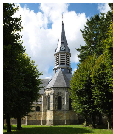
Vue du chevet. Phot. Marie-Laure Monnehay-Vulliet IVR22_20158000661NUC2A
