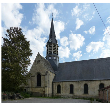
Vue des façades nord. Phot. Isabelle Barbedor IVR32_20188005126NUCA
