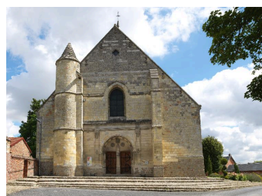
Façade occidentale. Phot. Marie-Laure Monnehay-Vulliet IVR22_20158000660NUC2A
