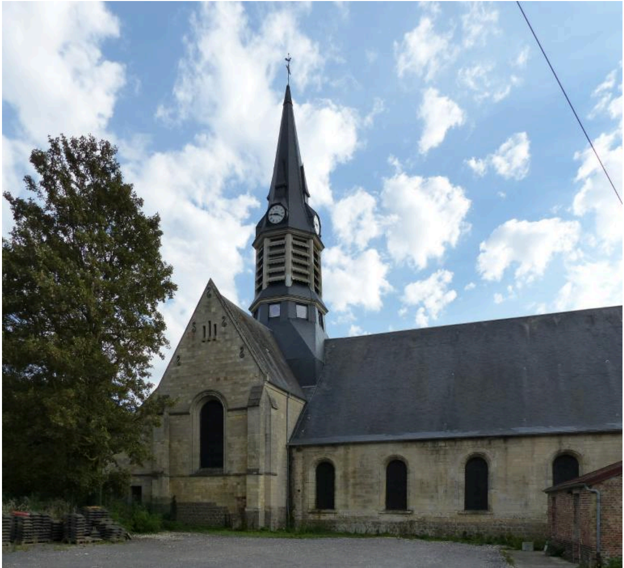
Vue des façades nord.
