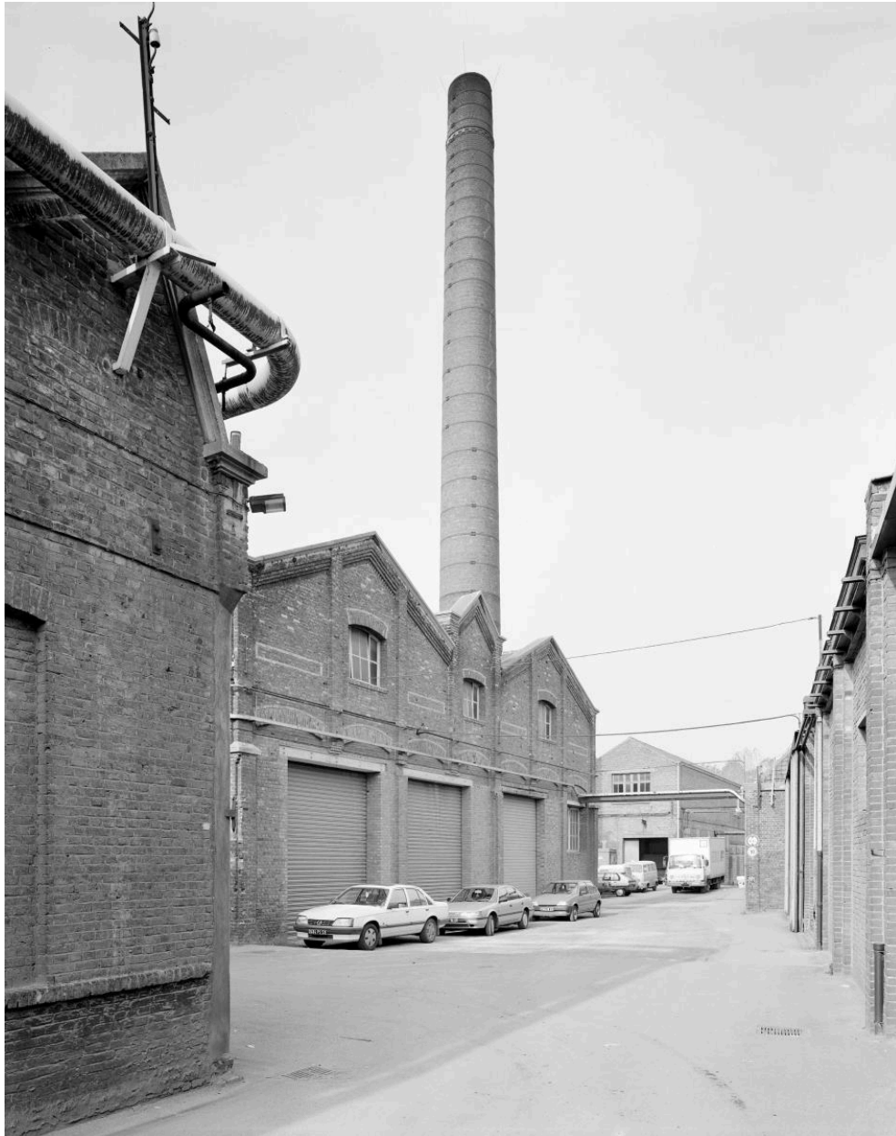
Chaufferie (ancien crémage). Vue prise vers le nord-ouest.
