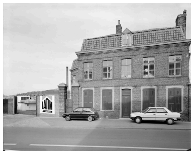
Entrée et habitation rue Victor-Hugo. Vue prise vers le nord. Phot. Olivier Marlard IVR31_19905901070V
