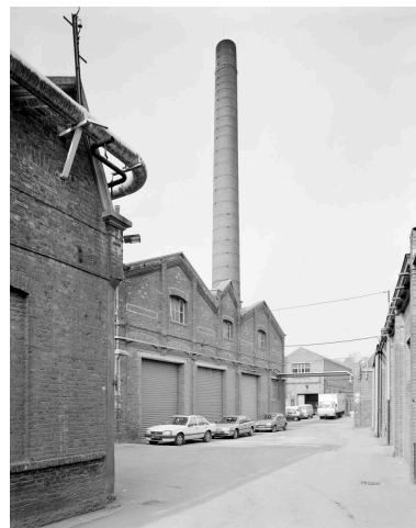
Chaufferie (ancien crémage). Vue prise vers le nord-ouest. IVR31_19905901069V
