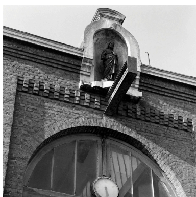
Salle des machines, élévation ouest, niche et statue du Sacré-Cœur. Phot. Olivier Marlard IVR31_19905901064X
