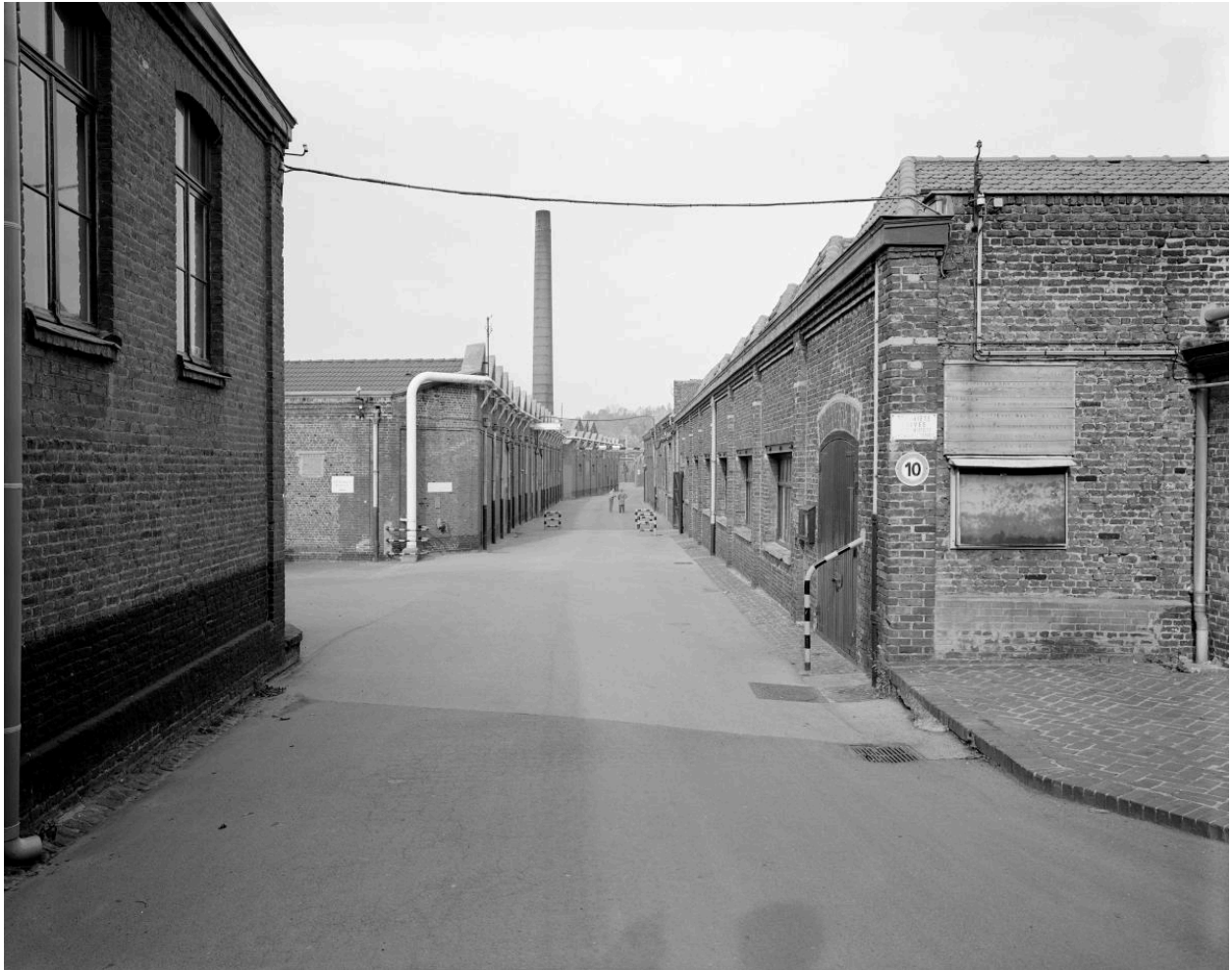
Vue depuis l'entrée (prise vers le nord).
