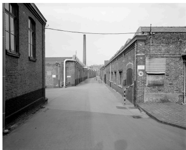
Vue depuis l'entrée (prise vers le nord). Phot. Olivier Marlard IVR31_19905901071V
