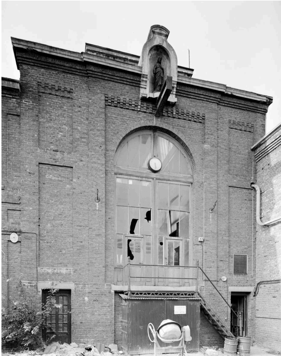
Salle des machines, élévation ouest.
