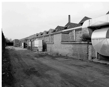
Tissage, élévation ouest. Vue prise vers le nord. Phot. Olivier Marlard IVR31_19905901065X
