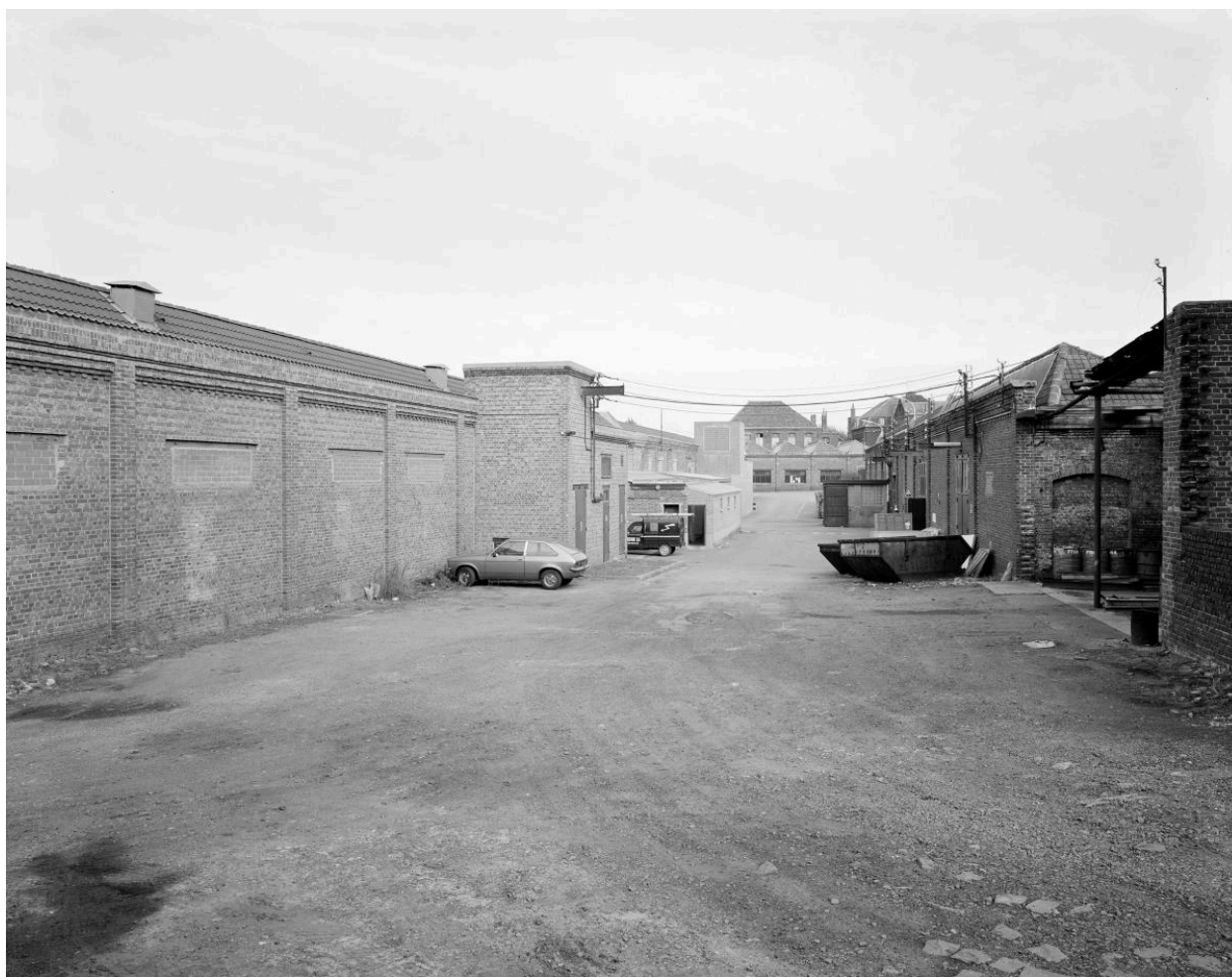
Atelier de fabrication, élévation sud. Vue prise vers l'est.
