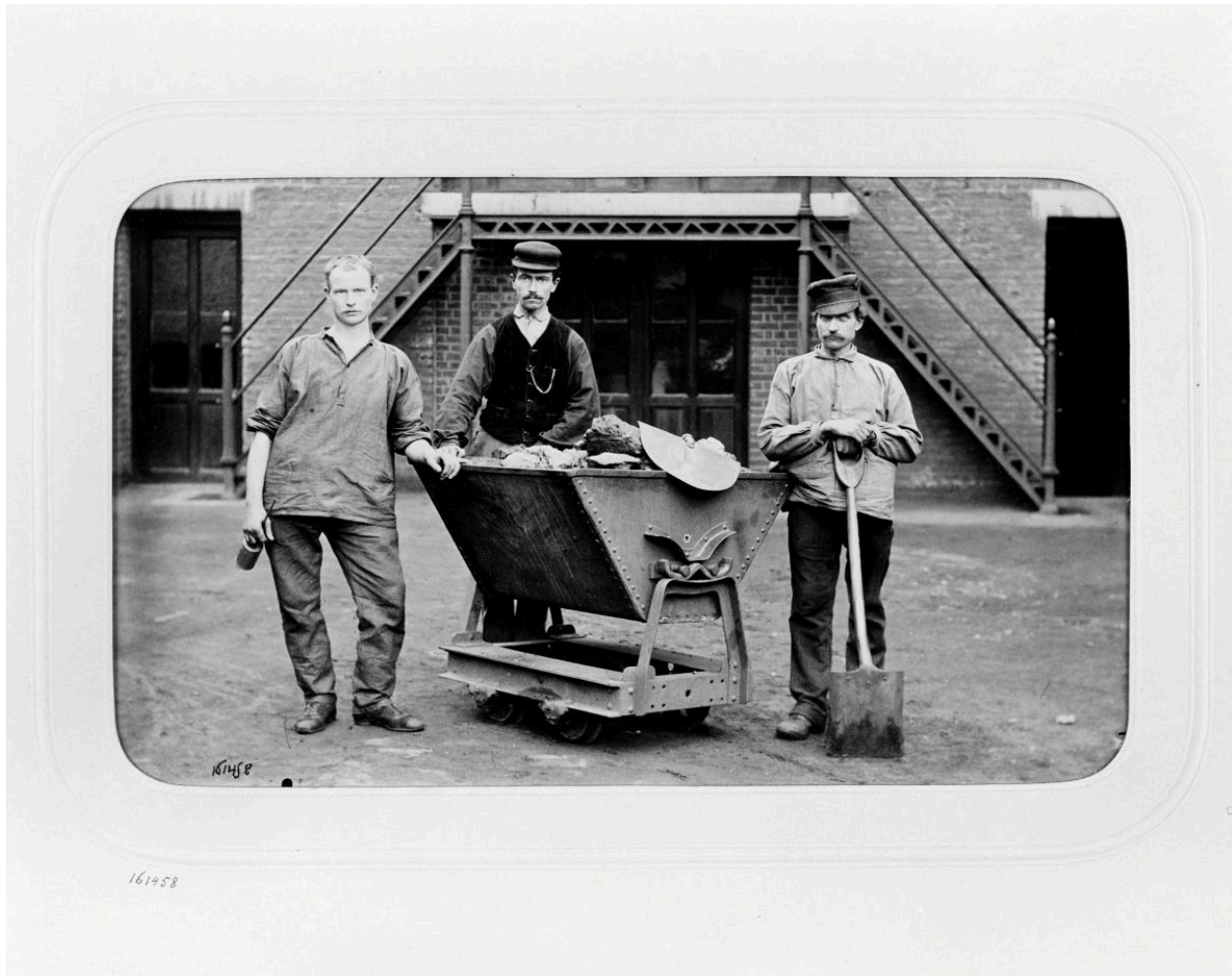
Chauffeurs de chaudières. Photographie de J. David, 1897 (AP Hacot et Colombier).
