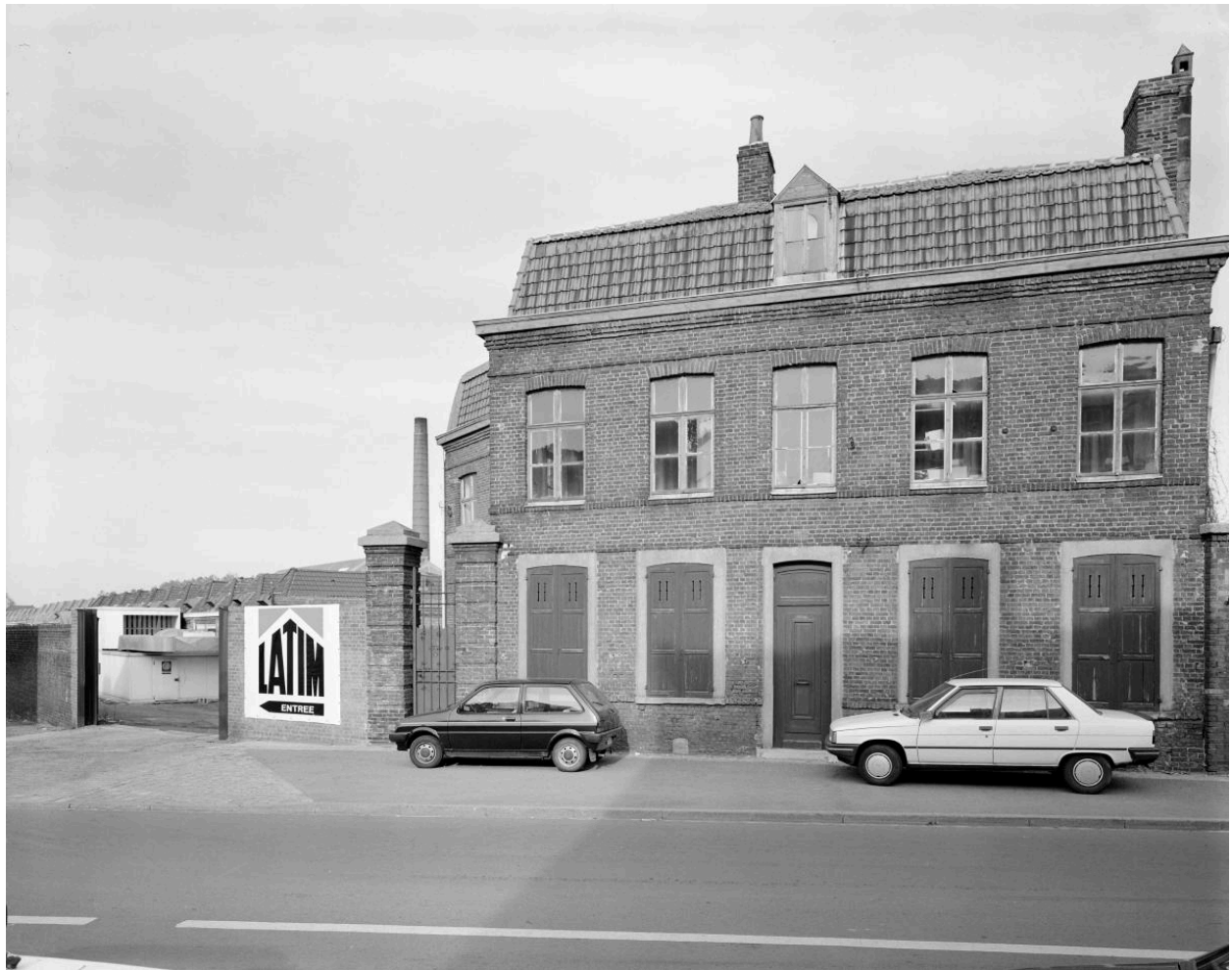
Entrée et habitation rue Victor-Hugo. Vue prise vers le nord.
