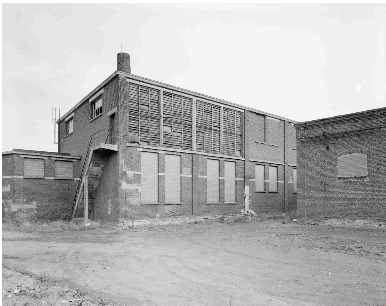
Magasin des toiles, atelier de fabrication, vers l'est.
